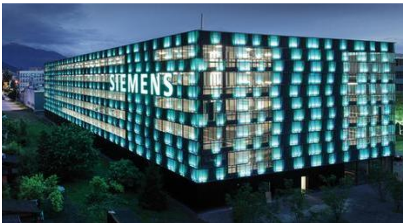
Abbildung 8: LED Fassade am Siemens Parkhaus in Zug
