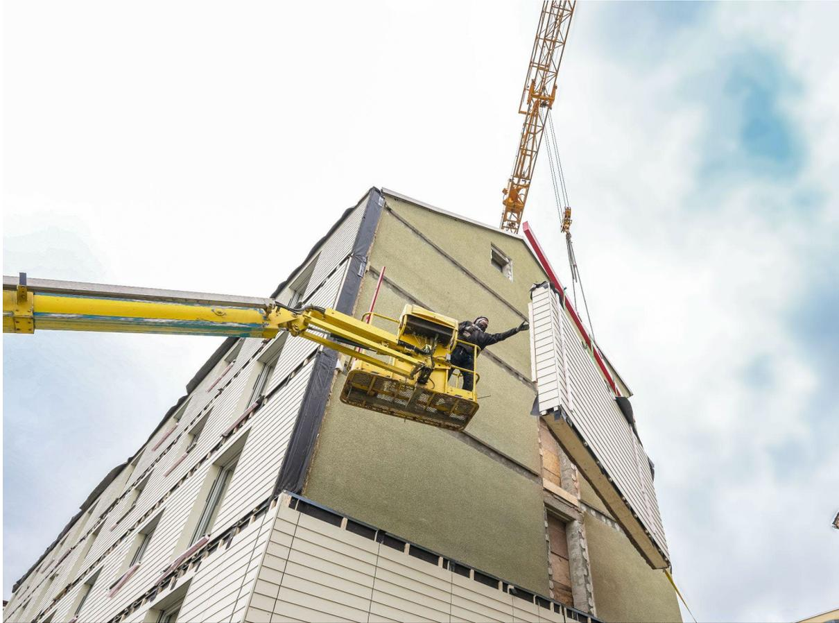
Abbildung 1: Serielle Sanierung mit ecoworks: Fassadenmontage in Greiz (2023) – Das Bestandsgebäude erhält innerhalb weniger Wochen eine neue Gebäudehülle aus passgenau produzierten Fassadenelementen mit integrierten Fenstern & Gebäudetechnik, mit Hilfe eines Hubwagens, ganz ohne Baugerüst.
