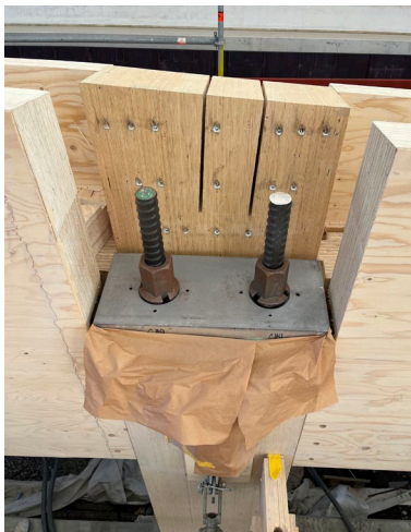
Abbildung 10: Stützenkopf während der Montage, noch nicht vorgespannt
