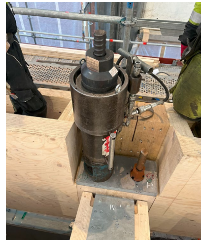
Abbildung 22 und 23: Montage Lage B (links), Vorspannprozess Spannglieder der Stützen (rechts)
