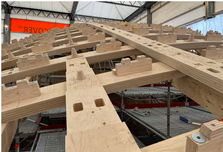
Abbildung 22 und 23: Montage Lage B (links), Vorspannprozess Spannglieder der Stützen (rechts)
