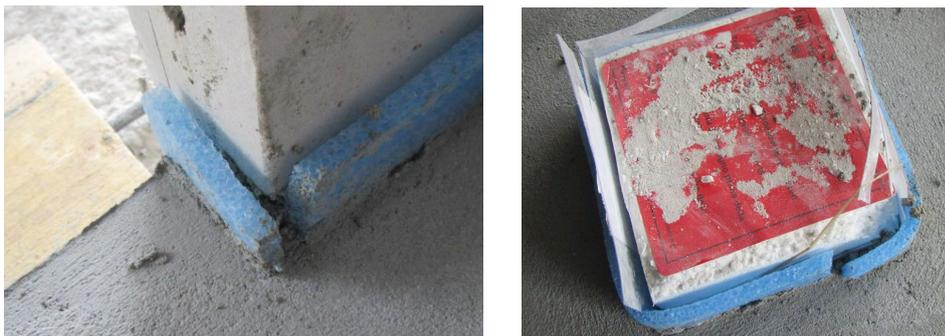
Abbildung 4: Beispiele von nicht durchgehenden Randstreifen bei einer Ecke und einem Deckendurchbruch
