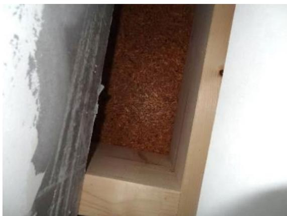
Abbildung 7: Einblick hinter die Akustikdecke in den Anschlussbereich der Innenwand an das Sparrendach. Durch Füllhölzer oder Mineralwollschotts im Bereich zwischen den Sparren kann die Flankenübertragung reduziert werden.
