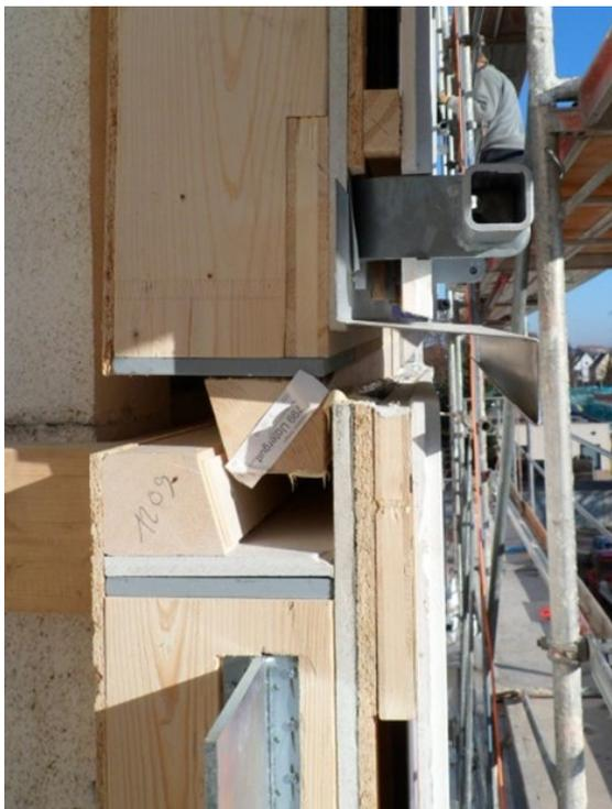
Abbildung 8: vertikaler Elementstoß
