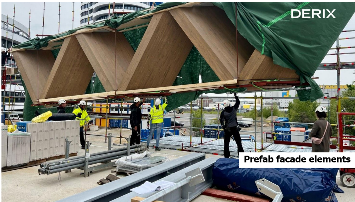
Abbildung 9: Montageprozess der vorgefertigten, gesteckten Elemente mit Heuballenenvlies (DERIX Gruppe)
