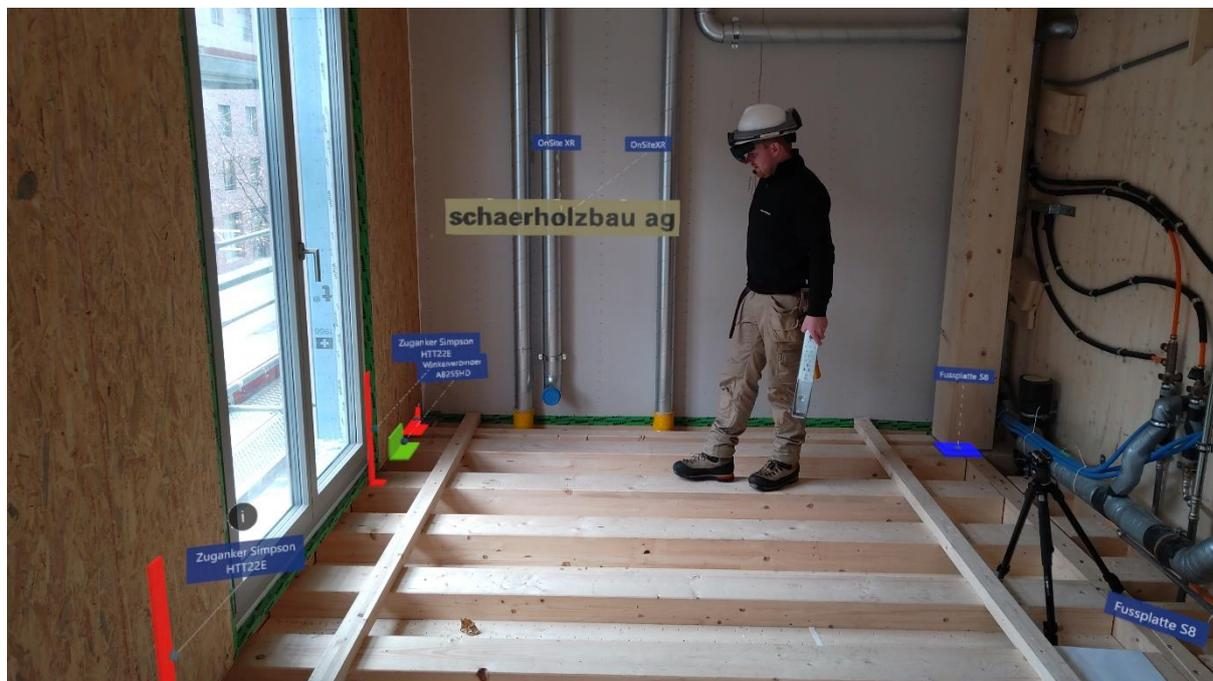
Abbildung 2: On Site App mit Hologrammen von statisch relevanten Verbindungsmitteln (Quelle afca)
