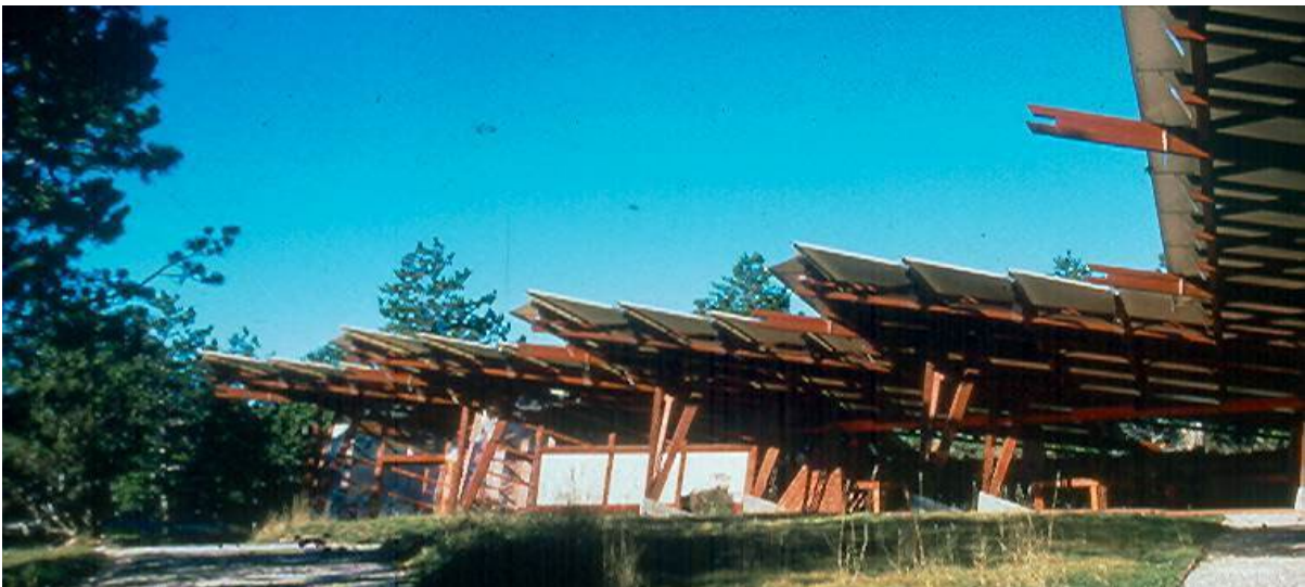
Abbildung 8: Balkenrost zur großzügigen schattenspendenden Überdachung mit vorgespannten Dachmembranen, die sich bei Bedarf streifenweise auswechseln lassen. Cantercel 1995, Architekt: Jean-Pierre Campredon Entwurf, Berechnung und Errichtung: Michael Flach, Jaques Anglade und Olivier Gaujard
