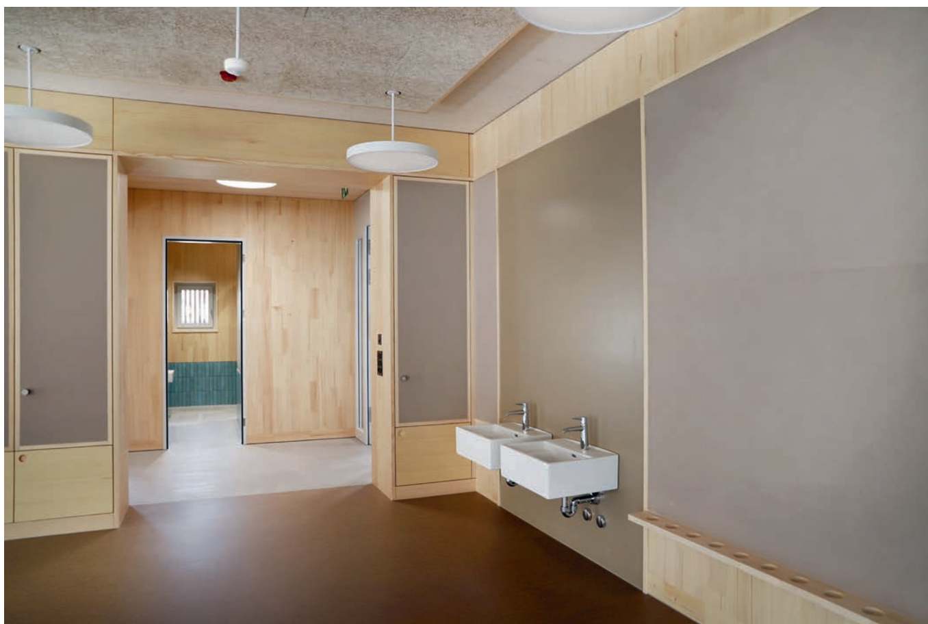
Blick von einem der vier Gruppenräume zum vorgelagerten Garderobenbereich und zu den Toiletten. Die Wände und die Einbauten bestehen aus transparent lackiertem Weissstannentäfer.
