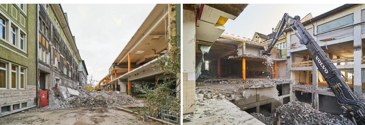
Abbildung 7 und 8: ELYS Teilrückbau des Gebäudes 215b zur Freilegung der gegenüberliegenden Fassade > neue Primarschule
