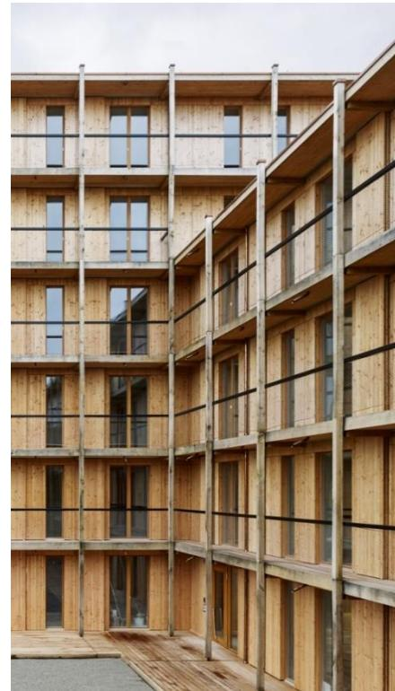
Abbildung 6: Holzfassade mit konstruktivem Wetterschutz, Foto: Georg Aerni
