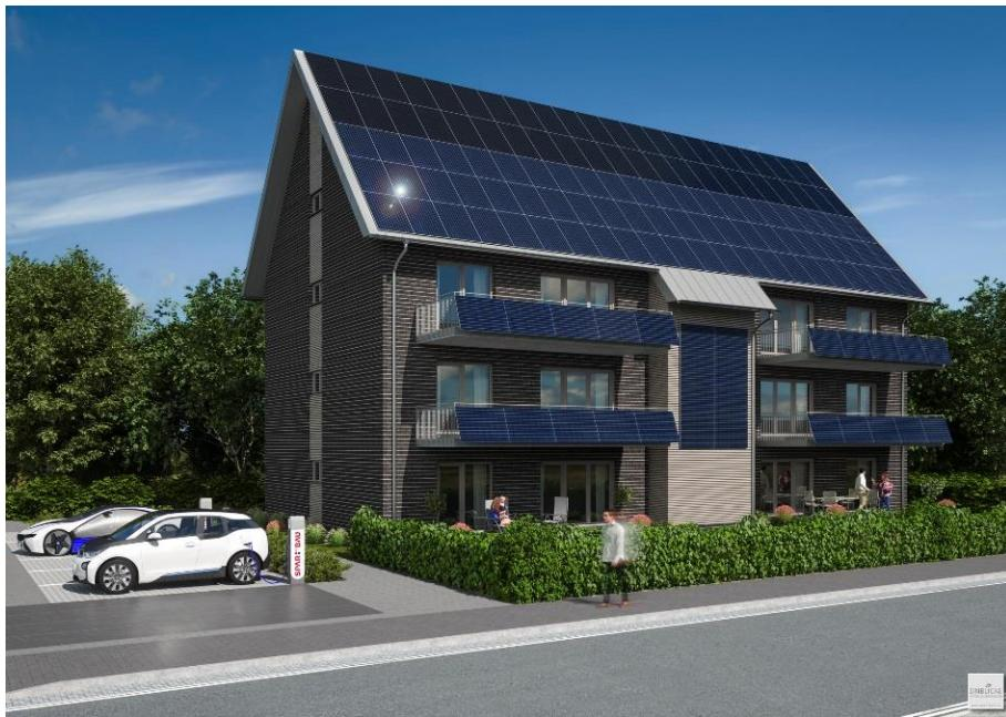
Abbildung 12: Mieten mit Energieflat: 6 Wohneinheiten in einem energieautarken Mehrfamilienhaus in Wilhelmshaven, Fertigstellung 2018. Solartechnik auf dem Dach und an den Balkonen mit Energiespeicher erreichen etwa 70 Prozent solare Deckung des Strom- und Wärmebedarfs.
