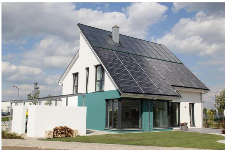
Abbildung 3: Erstes bezahlbares energieautarkes Eigenheim Europas als unbewohntes Musterhaus in Lehrte/Hannover von der HELMA Eigenheimbau AG Baujahr 2011. Es versorgt sich selbst mit Wärme, Strom und E-Mobilität: durch Solarthermie (mit Langzeitwärmespeicher), Photovoltaik (mit Akku) sowie etwas Biomasse. Primärenergiebedarf: 7 kWh/m<sup>2</sup>a.
