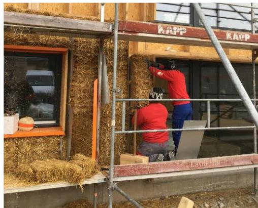
Bild 13: Einbau der Strohballen
