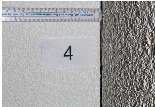
Abbildung 9: Innenecke mit geöffneter Fuge
