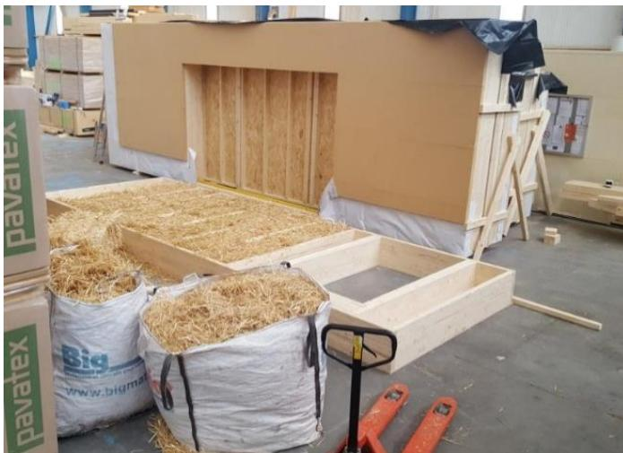
Bild 18: Vorfertigung der Wände
