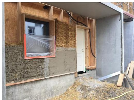
Bild 15: Aufbringen der verschiedenen Putzschichten
