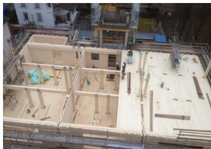
Bild 26: Tragkonstruktion während der Montage
