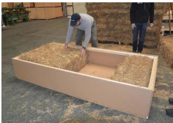
Bild 27: Vorfertigung der Isolierung
