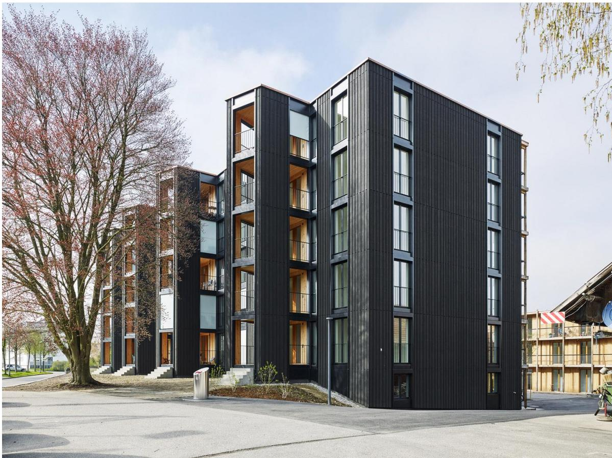
Abbildung 10: Mineralisch geschleimte Holzfassade mit Außenzimmern, Foto: Georg Aerni
