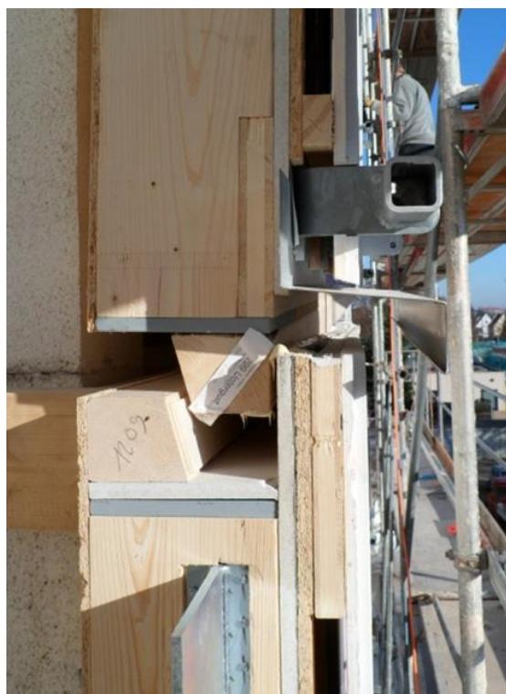
Abbildung 8: vertikaler Elementstoß
