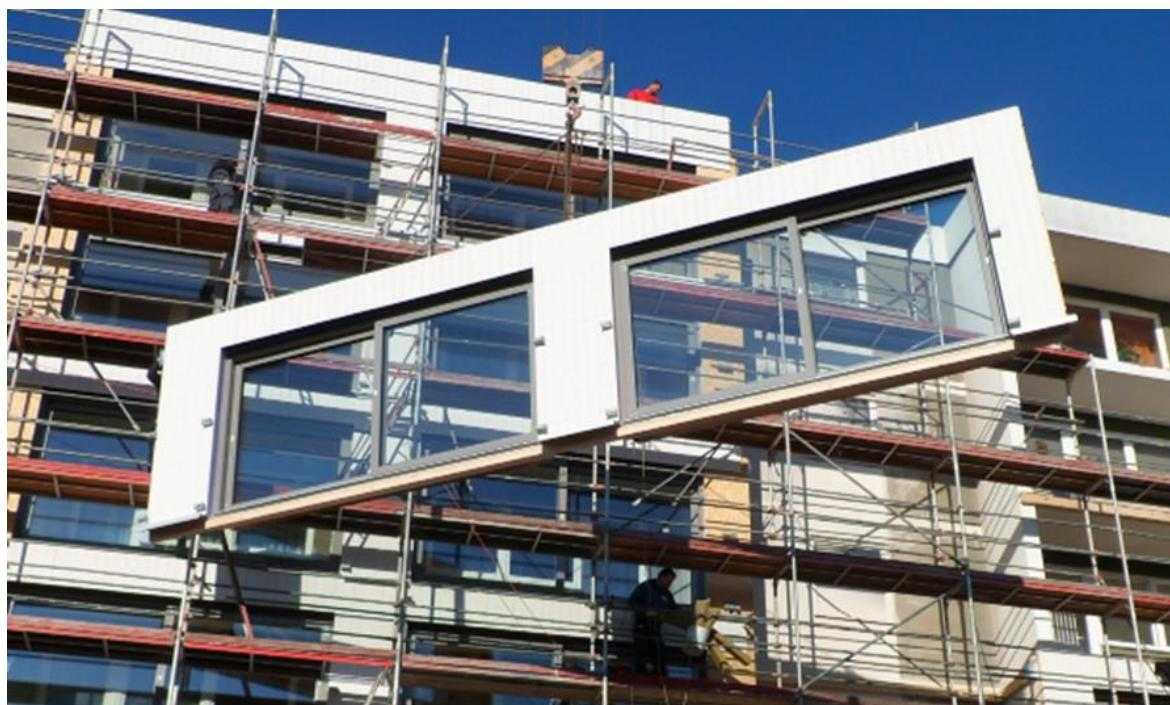
Abbildung 5: Montage TES Element
