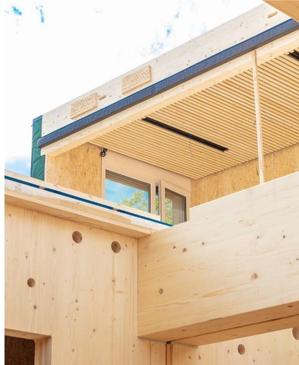
Abbildungen 13 und 14: (Links) Mit luftigem Abstand kommen die Elemente der Bodenplatte auf die Einzel-fundamente. (Rechts) Die Raummodule enthalten bereits alles Wesentliche wie Fenster, Akustikdecke etc. (©13: werk.um architekten, ©14: digitalgrafie/Blitzwerk)
