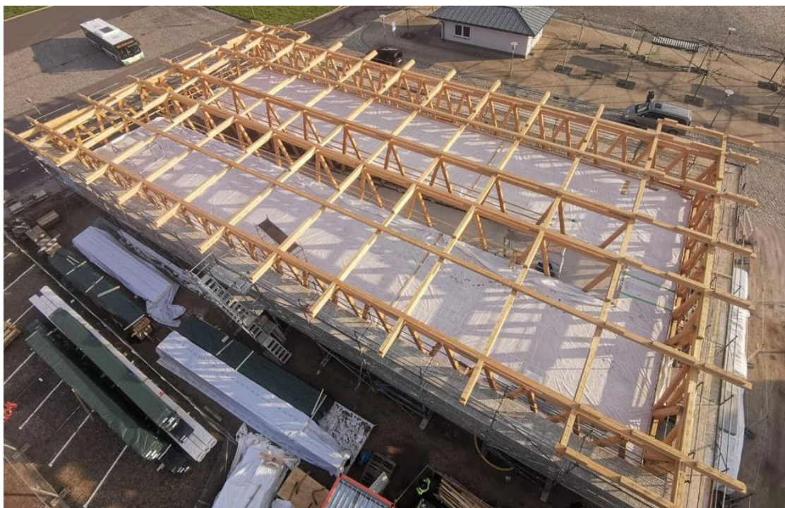
Abbildung 4: Foto Bauzustand (Leitplan GmbH)
