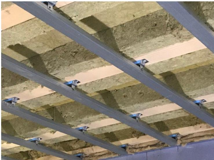
Abbildung 6: vormontierbares Abhängesystem mit minimaler Abhängehöhe z.B. Knauf VF5
