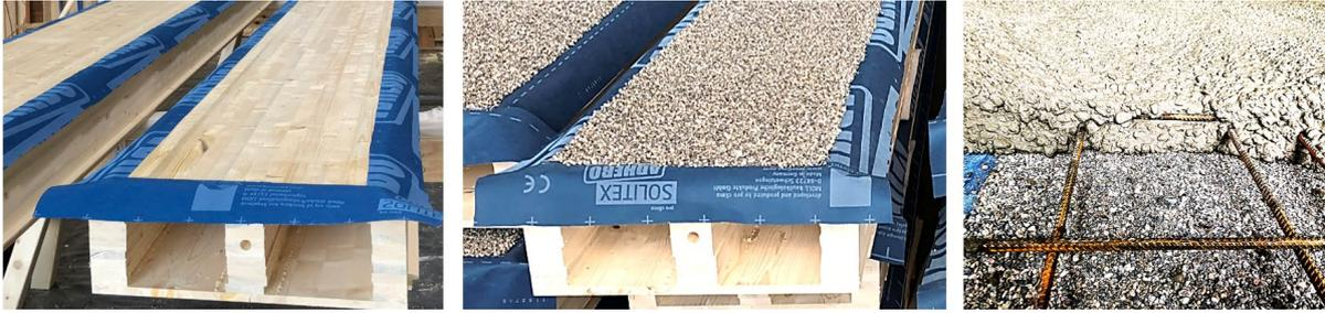
Abbildung 9: Holzelemente vor und nach dem Aufbringen des Granulatsplitts und beim Betonieren
