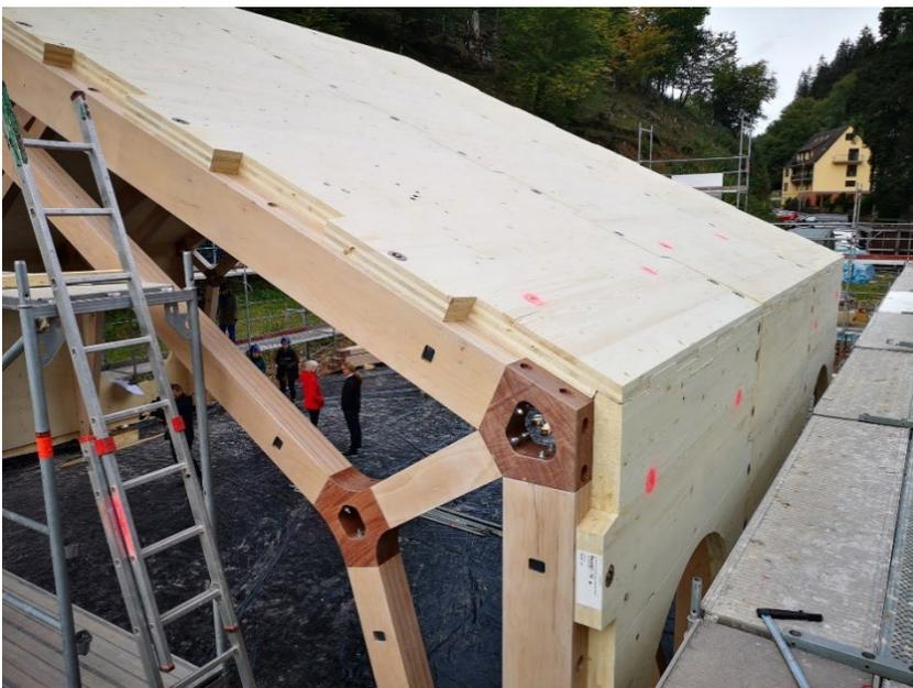
Abbildung 13: Werk- und Forschungshalle: Bauphase – Reversible Verbindungen aller Bauelemente mit formschlüssigen Verbindungen, z. B. mit Konusadaptern
