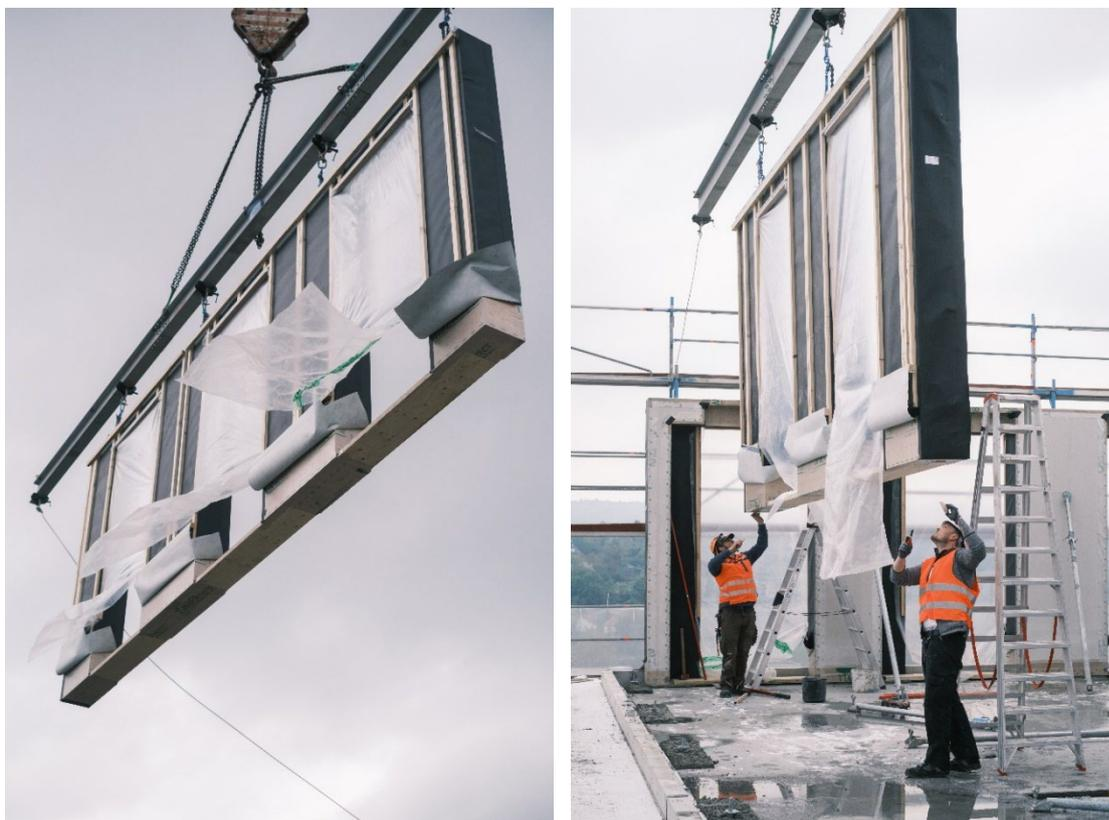
Abbildung 10+11: Montage der vorgefertigten Wandelemente, welche «just-in-time» auf die Baustelle geliefert wurden © Christoph von Zepelin
