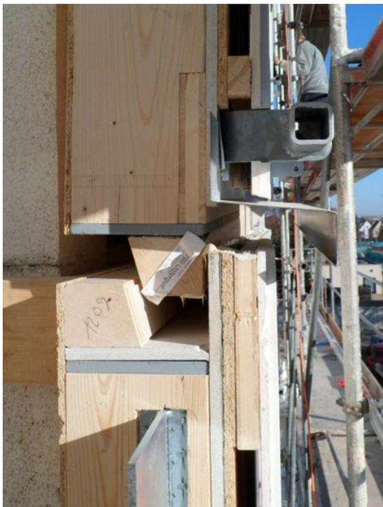
Abbildung 8: vertikaler Elementstoß
