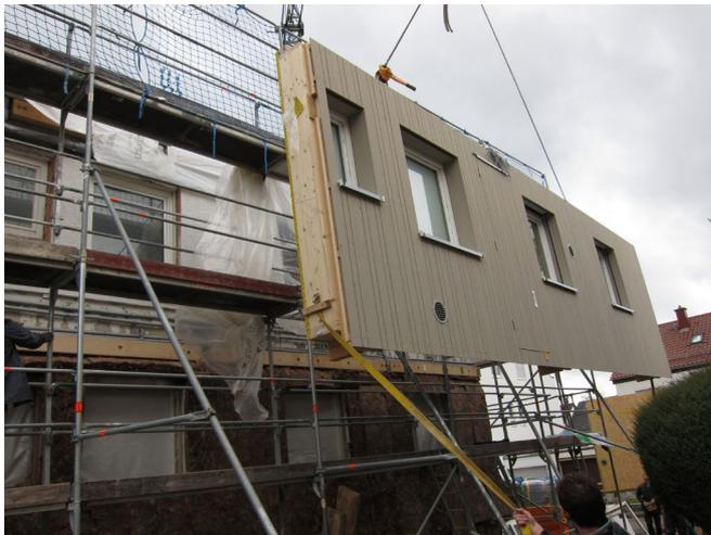
Abbildung 1: Beispiel einer seriellen Sanierung mit vorgefertigter Holzfassade (Quelle: EU Fp7 Projekt Inspire), siehe auch [6]
