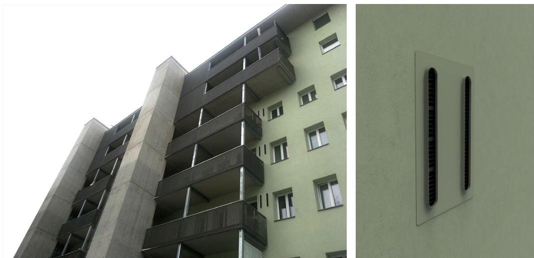
Abbildung 6: Virtuelle Demo in Innsbruck mit fassadenintegrierter Wärmepumpenaußeneinheit (Gebäude: IIG, Rendering: element Design)
