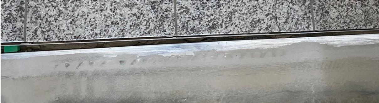
Abbildung 5: Übergang Treppenraum zu Nutzungseinheit, die Fugen wurden nach Feststellung einer starken Trittschallübertragung wieder geöffnet. Da: optimale Körperschallübertragung durch direkten Kontakt der Abschlussleiste mit dem Fliesenbelag im Treppenraum und Fußbodenbelag innerhalb der Nutzungseinheit. Hier sollte eine dauerelastischen Fuge (Silikon) vorgesehen werden.
