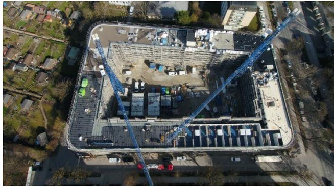
Abbildung 5: Dante II – Montage mit 2 stationären Kränen
