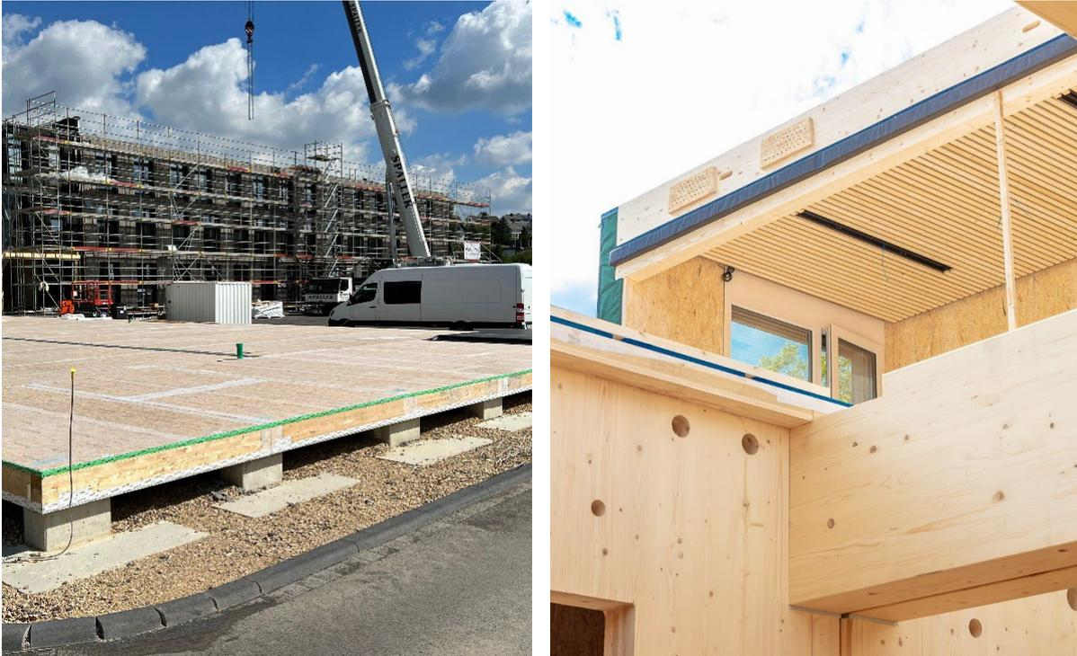
Abbildungen 13 und 14: (Links) Mit luftigem Abstand kommen die Elemente der Bodenplatte auf die Einzel-fundamente. (Rechts) Die Raummodule enthalten bereits alles Wesentliche wie Fenster, Akustikdecke etc. (©13: werk.um architekten, ©14: digitalgrafie/Blitzwerk)
