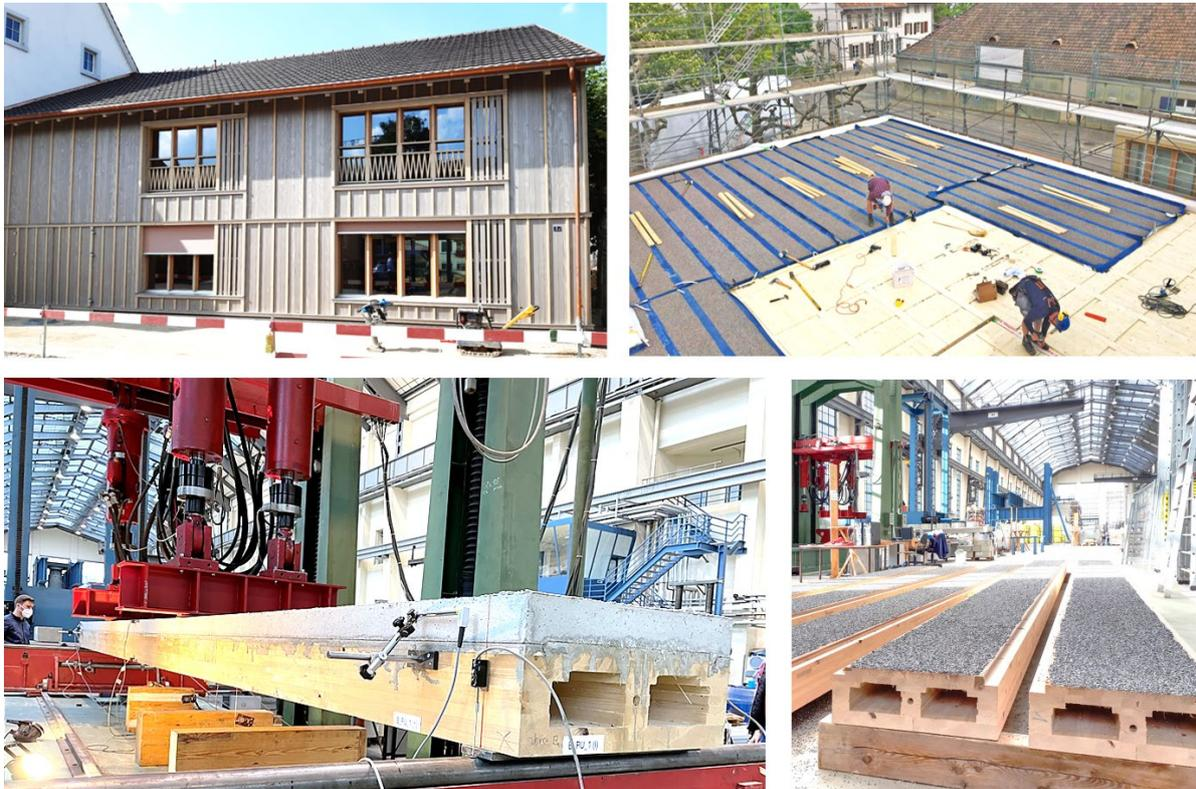
Abbildung 13: oben: Doppelkindergarten Sissach, li: Ansicht re: Holzlage der HBV-Decke © Beer Holzbau AG
