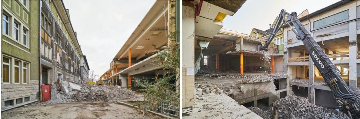
Abbildung 7: ELYS Teiltrückbau des Gebäudes 215b zur Freilegung der gegenüberliegenden Fassade > neue Primarschule
