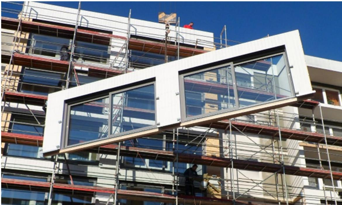
Abbildung 5: Montage TES Element
