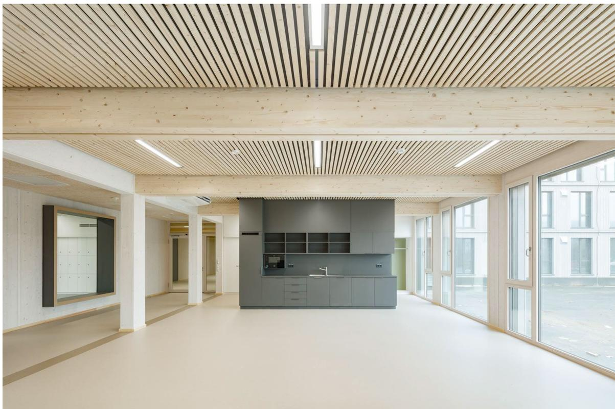
Abbildung 15: Das spätere Lehrerzimmer im EG. Der Linoleumboden zieht sich durch das ganze Gebäude.
