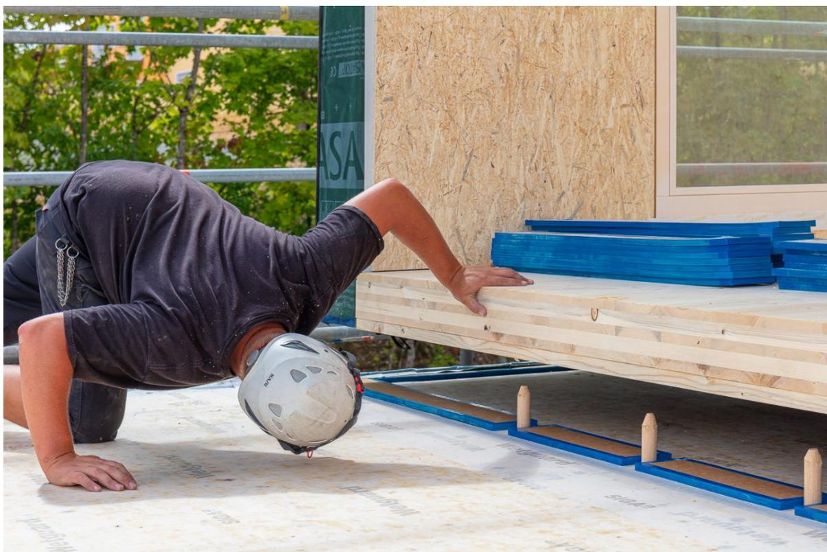
Abbildung 12: Ein Modul wird eingepasst, die Verbindung erfolgt nur über Holzrollen (© digitalgrafie/Blitzwerk)
