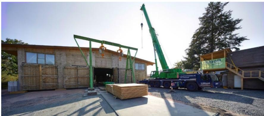
Abbildung 9: Die Feldfabrik – eine mobile Montagehalle aus massivem Holz ©skykamera
