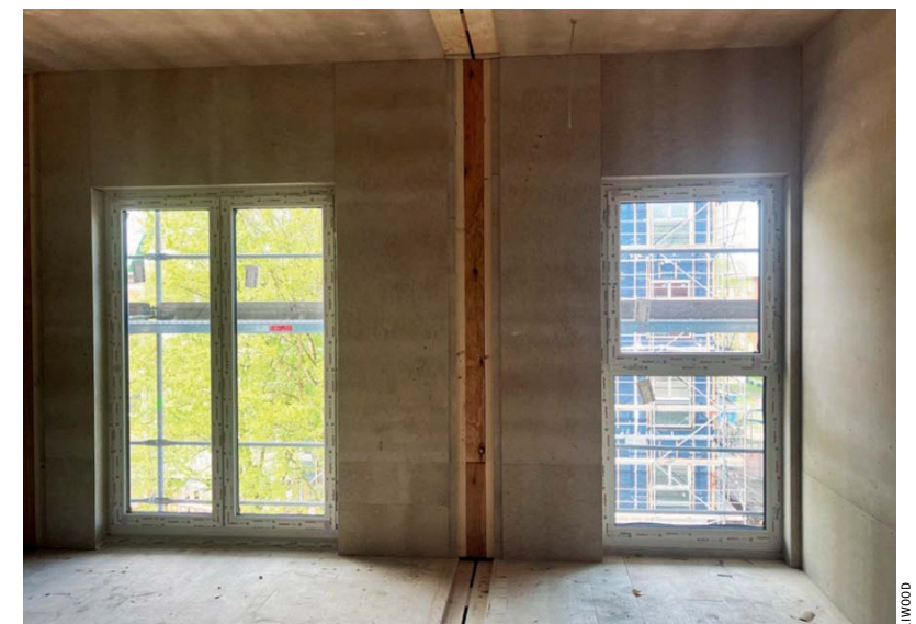
► Zwei Module nach dem direkten Versetzen mit noch nicht verschlossenen Modulfugen
