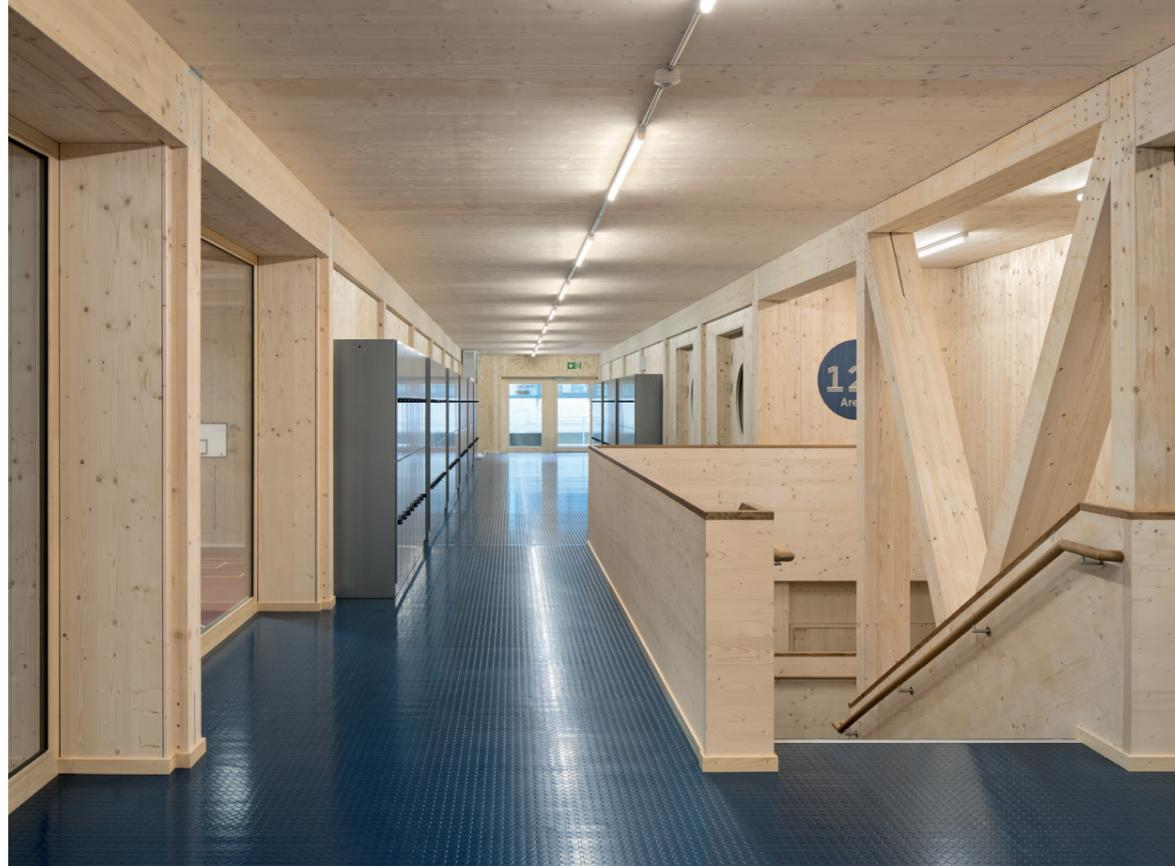
Wo möglich, kam unverleimtes, unbehandeltes Holz zum Einsatz. Wo statisch nötig, verbaute man Brettschichtholzträger.
