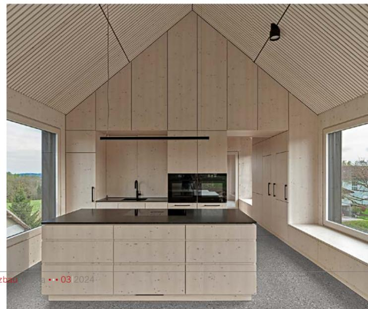
**Ein Brettsperrholz-Bau durch und durch**
