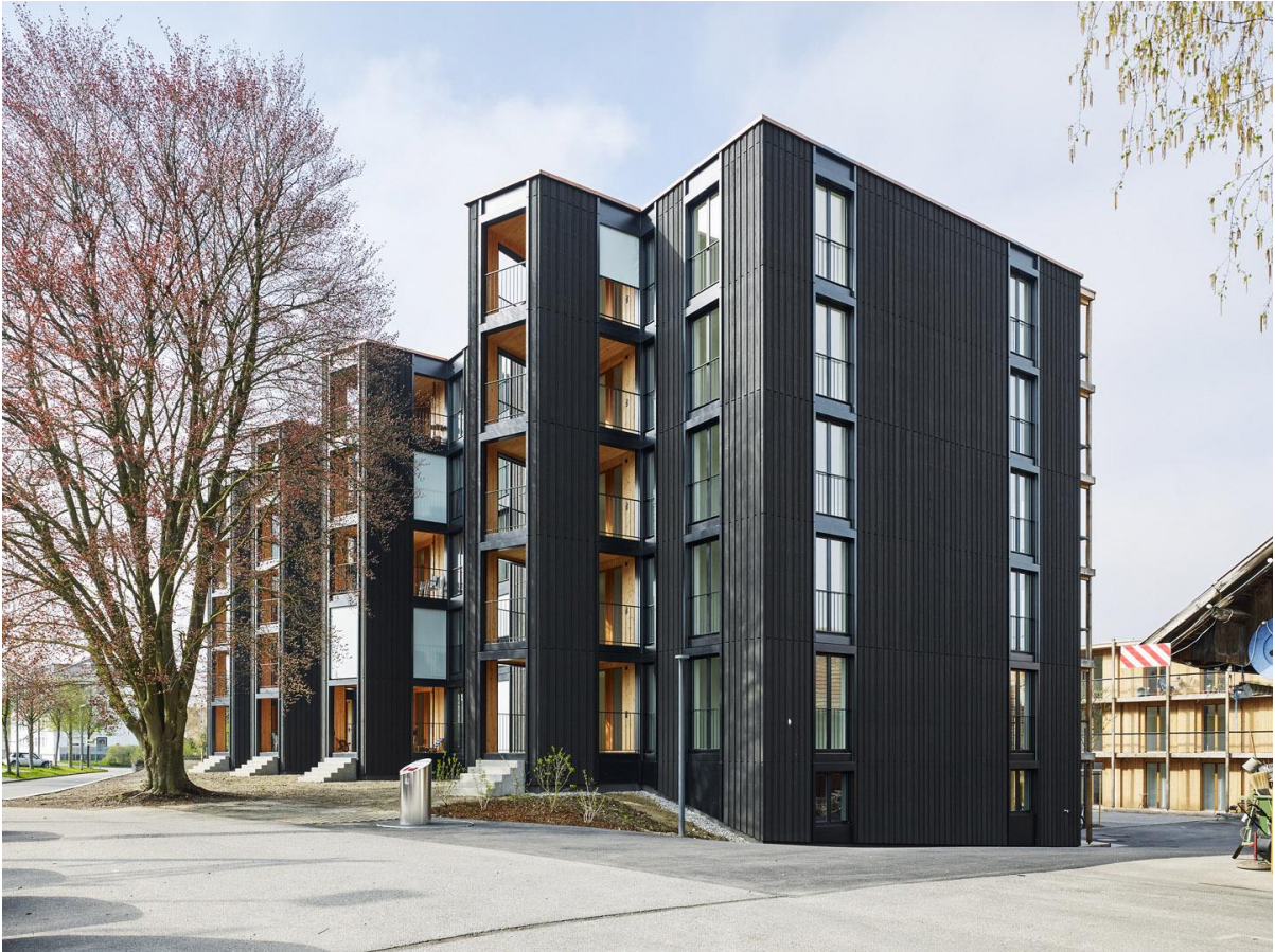
Abbildung 10: Mineralisch geschlemmte Holzfassade mit Außenzimmern, Foto: Georg Aerni
