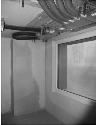
Abbildung 4: Lüftungsverteilung in Wohnung
