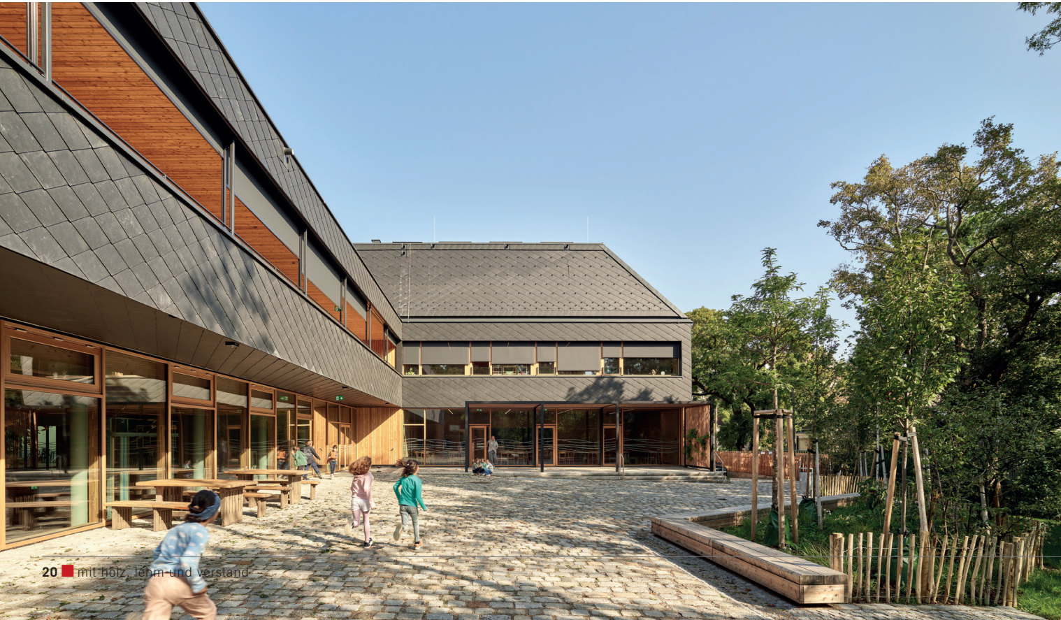
Die neuen Klassenzimmer werden über gartenseitige Laubengänge erschlossen. Diese sorgen auch für viel Tageslicht in den Innenräumen.
