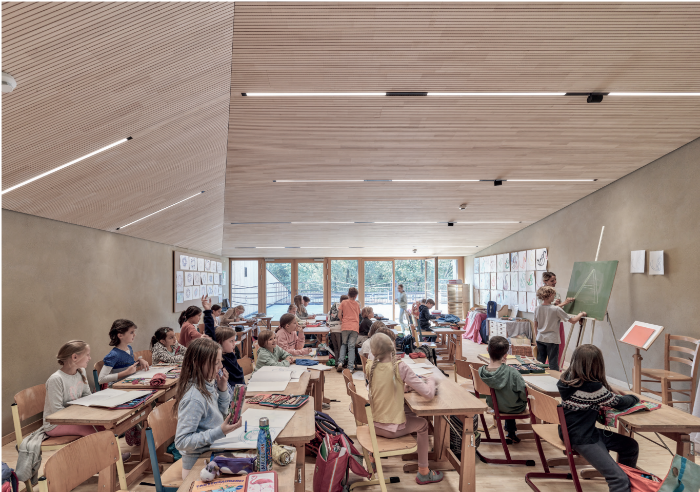
Im Innenraum sind alle Trennwände in Holzständerbauweise, mit Holzfaserdämmung und Lehmoberflächen ausgeführt. Diese erfüllen nicht nur die hohen bauphysikalischen Anforderungen an ein Schulgebäude, sondern verbessern auch das Raumklima.
