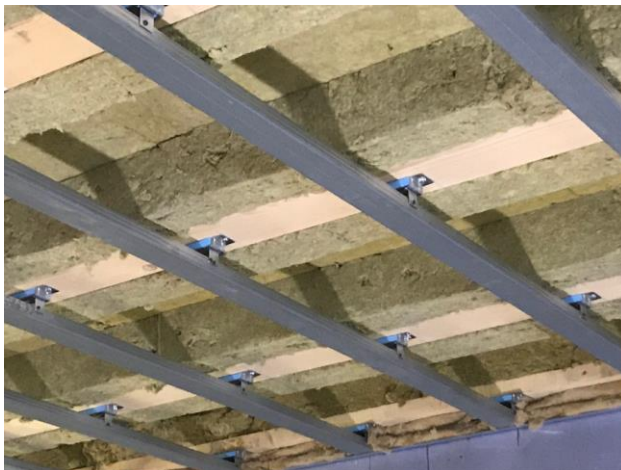
Abbildung 14: Deckenabhängung mit optimierten Elastomeren und CD-Profilen
