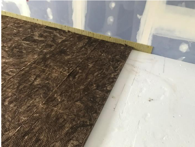
Abbildung 13: Ausführung der Trittschalldämmung mit Mineralfaser in gleicher Weise der Randdämmstreifen
