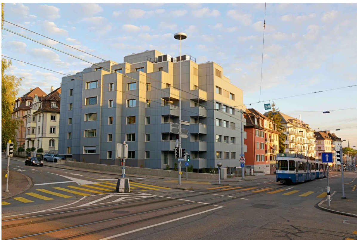
Abbildung 1: Die beiden sanierten Mehrfamilienhäuser an der Hofwiesen-/Rothstrasse in Zürich
