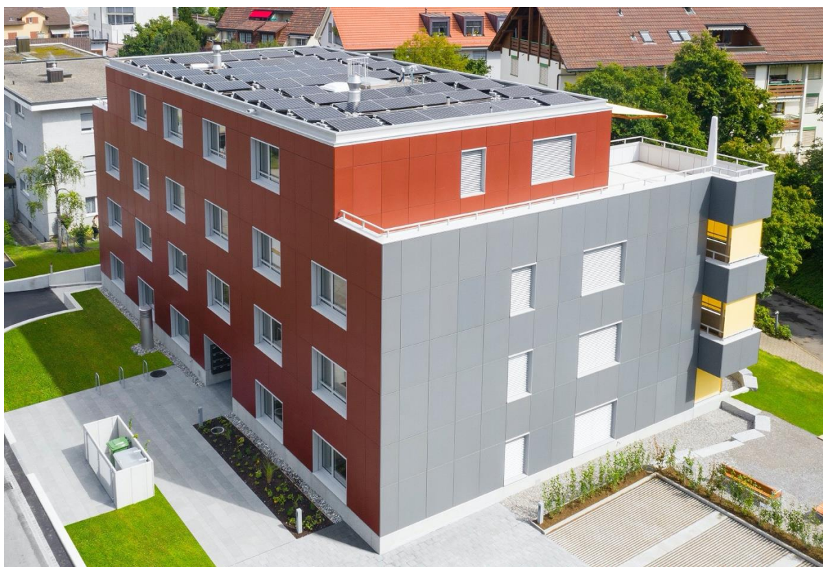
Abbildung 2: Der Ersatzneubau Seewadelstrasse in Affoltern am Albis
