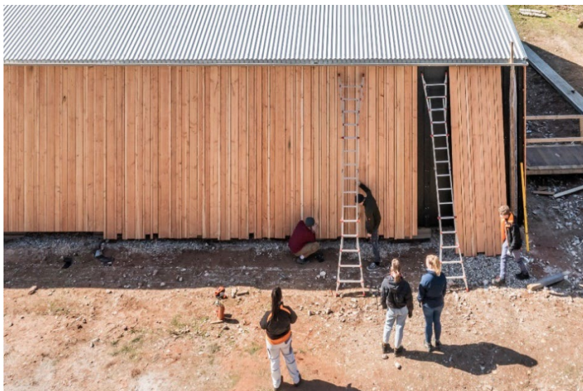
Abbildung 10: Werk- und Forschungshalle: Douglasienfassade, in 1,25 m Elementen vorgefertigt.
