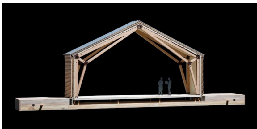
Abbildung 11: Detailmodell Werk- und Forschungshalle: Kriechkellerkonstruktion. Quelle t-lab
