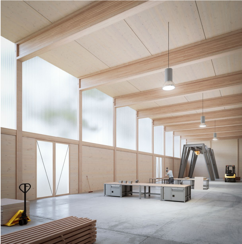
Abbildung 5: Beispielhafter, kreislauffeffektiver Werkhallenentwurf (16 m Spannweite, 4,50 m Trägerabstand und lichte Raumhöhe von 7 m) mit standardisierten I-profilierten Buchenholzhybridträgern auf Stützen [12]. (Visualisierung: t-lab / Nicolai Becker Images, Stuttgart)
