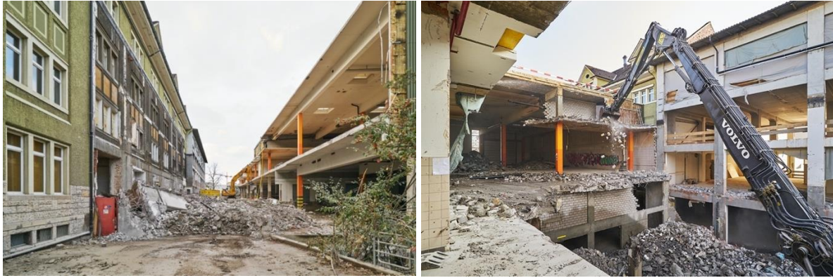
Abbildung 7 und 8: ELYS Teilrückbau des Gebäudes 215b zur Freilegung der gegenüberliegenden Fassade > neue Primarschule
