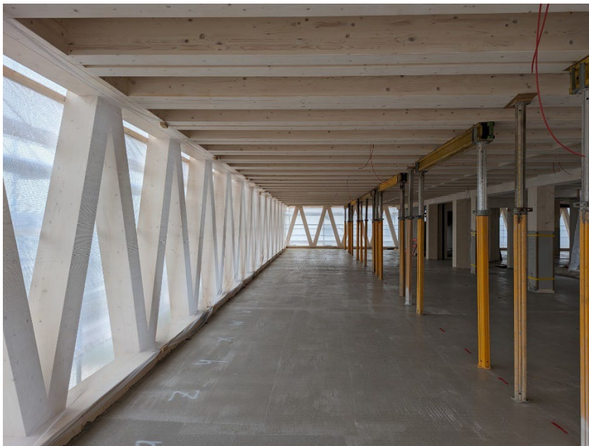
Abbildung 7: Fertig montiertes Tragwerk
