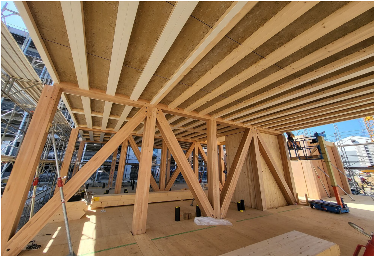
Abbildungen 13: Montage des ersten, der fünf Geschosse und der Bodenelemente des HORTUS-Baus.
