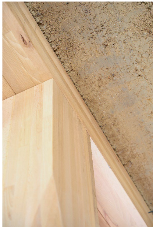
Abbildung 6: Die Holz-Lehm-Verbundelemente wurden speziell für den HORTUS-Bau entwickelt.
