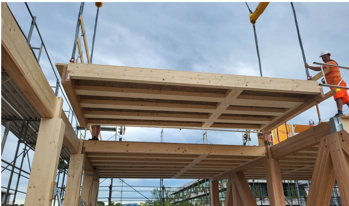
Abbildungen 13: Montage des ersten, der fünf Geschosse und der Bodenelemente des HORTUS-Baus.
