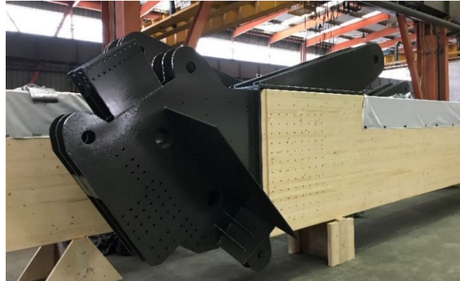
Abbildung 9: Knotenanschluss am Kopfpunkt der Stützen
