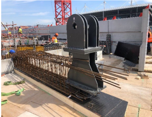
Abbildung 8: Fußpunkt der Zugverankerung
