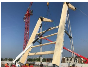
Abbildung 10: Montage der ersten Stützen im Frühjahr 2022
