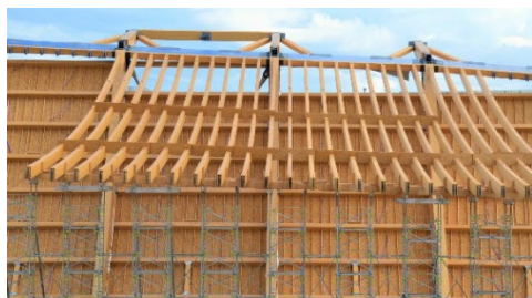
Abbildung 11: Montage der ersten Segmente der Hängeträger im Sommer 2022
