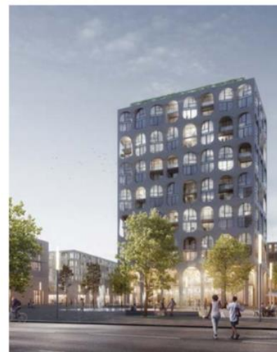
Stadtteilzentrum Freiham München (in Bau) DGNB Gold
