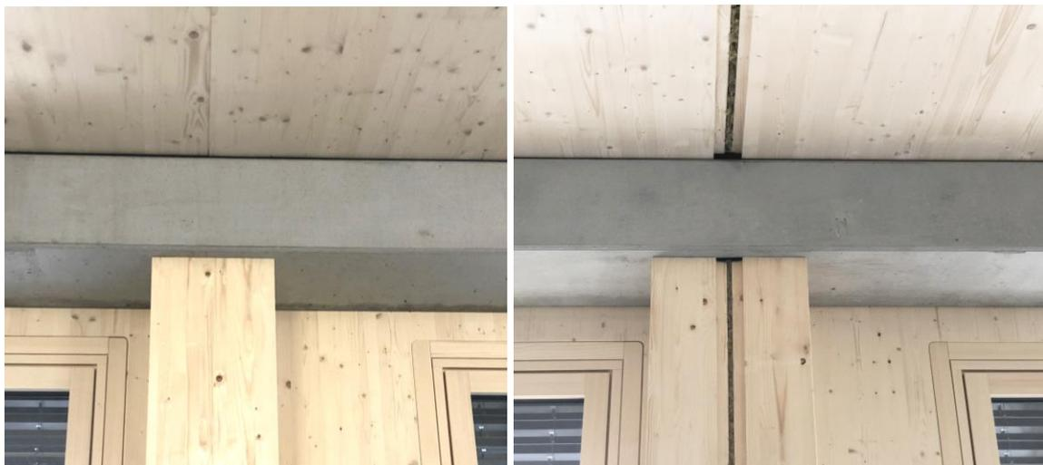
Abbildung: Fotos: Ausführung ohne/mit Schalltrennfugen
