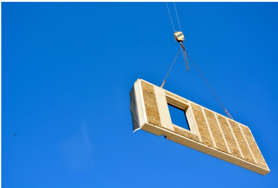
Seminargebäude Haus St. Wunibald, vorgefertigte Wandelemente aus Holz-Tafelementen; Foto: Lorenz Maertl Copyright Benediktinerabtei Plankstetten
