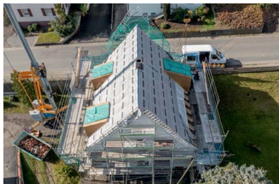
▲ Bereits beim Ausmessen des Dachs werden die Gaubenpläne präzise an variierende Dachneigungen oder verzogenes Gebälk angepasst
