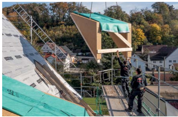
▲ Die Gauben wurden beim Dämmstoffhersteller Linzmeier aus Sandwichelementen vorgefertigt und kamen als Bauteile auf die Baustelle
