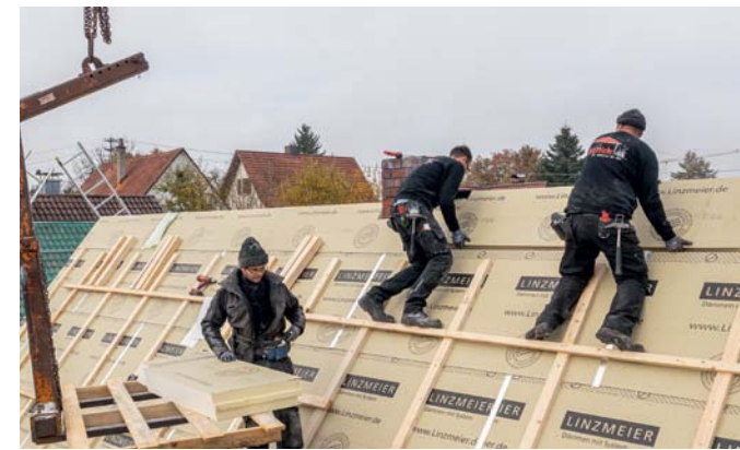
▲ Die Dämmelemente wurden, beginnend bei einer parallel zur Traufe montierten Knagge, in Reihen von unten nach oben verlegt
