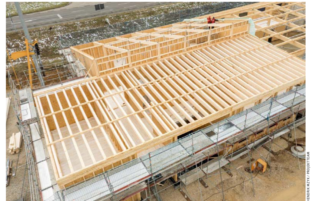
▲ 51 m³ BSH: Die Dachkonstruktion wurde als weit gespannte BSH-Tragstruktur ausgeführt
