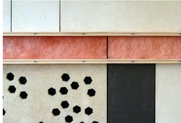
Abbildung 2: Musterfassade mit unterschiedlich farbigen Holzleichtbeton-Platten, Nürnberg 2012 [Photo: Autor]
