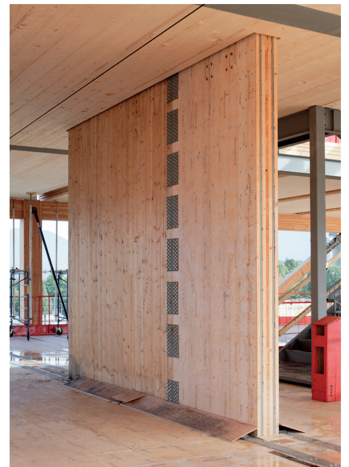
Brettspertholzdecken und Brett-schichtholzträger bilden das Tragwerk der Büroflächen und schaffen offene, flexibel nutzbare Grundrisse.
