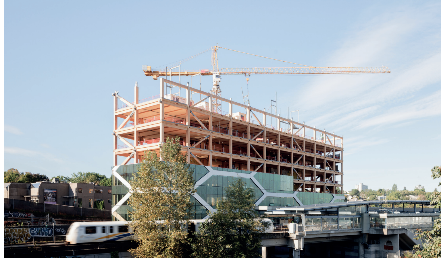
Das zehnstöckige Bürogebäude besteht aus neun Holzgeschoßen auf einem Betonsockel und setzt neue Maßstäbe für den urbanen Holzhochbau.
