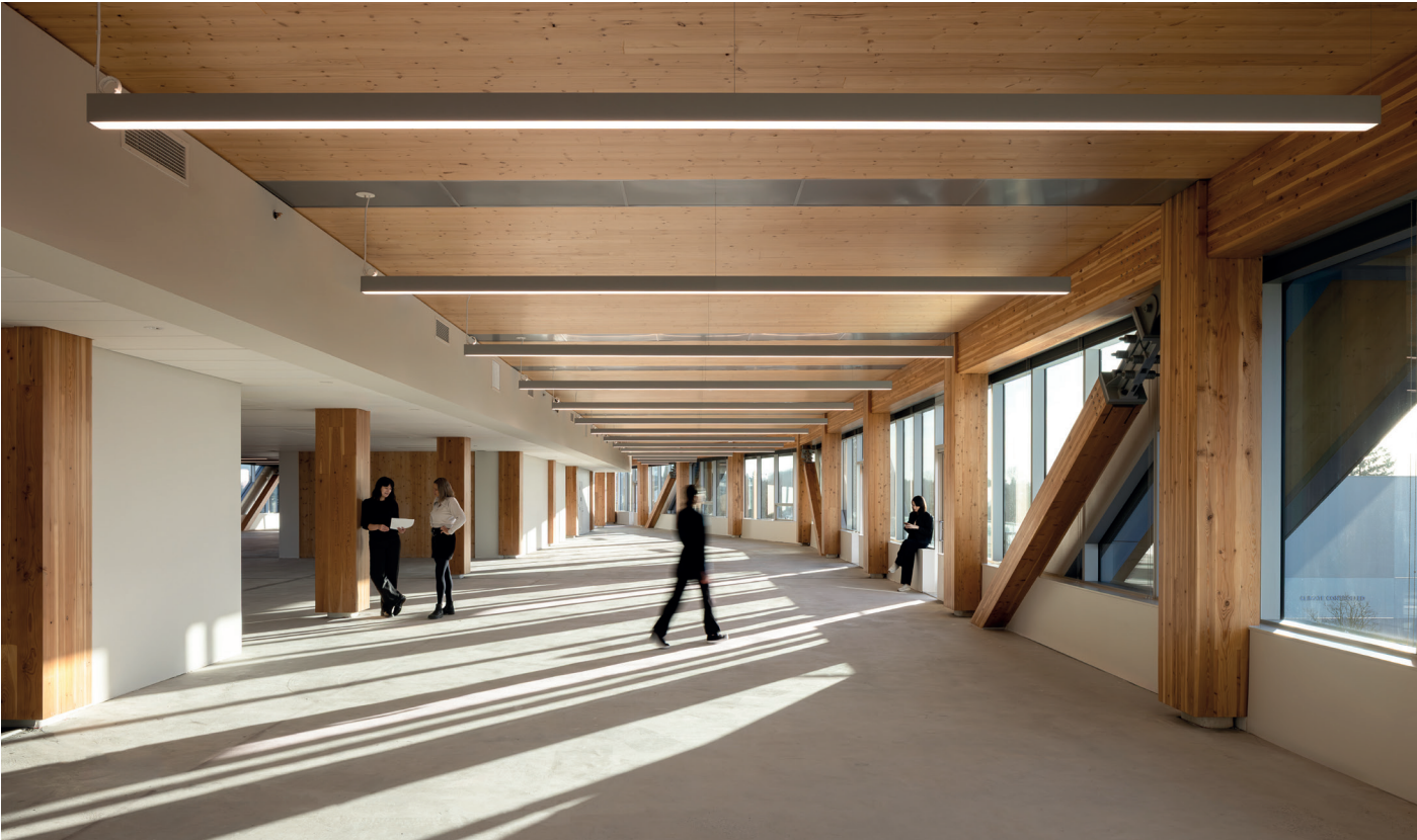
Mit rund 15.300m 2 Bürofläche zeigt The Hive, wie nachhaltiger Holzbau und moderne Ingenieurkunst im urbanen Raum zusammenfinden.
