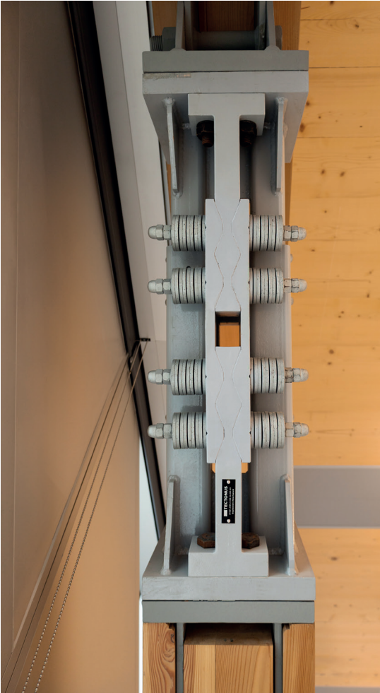
Die Tectonus-Dämpfer ermöglichen kontrollierte Bewegungen während eines Erdbebens und helfen dem Gebäude, anschließend selbstständig in seine Ausgangsposition zurückzukehren.
