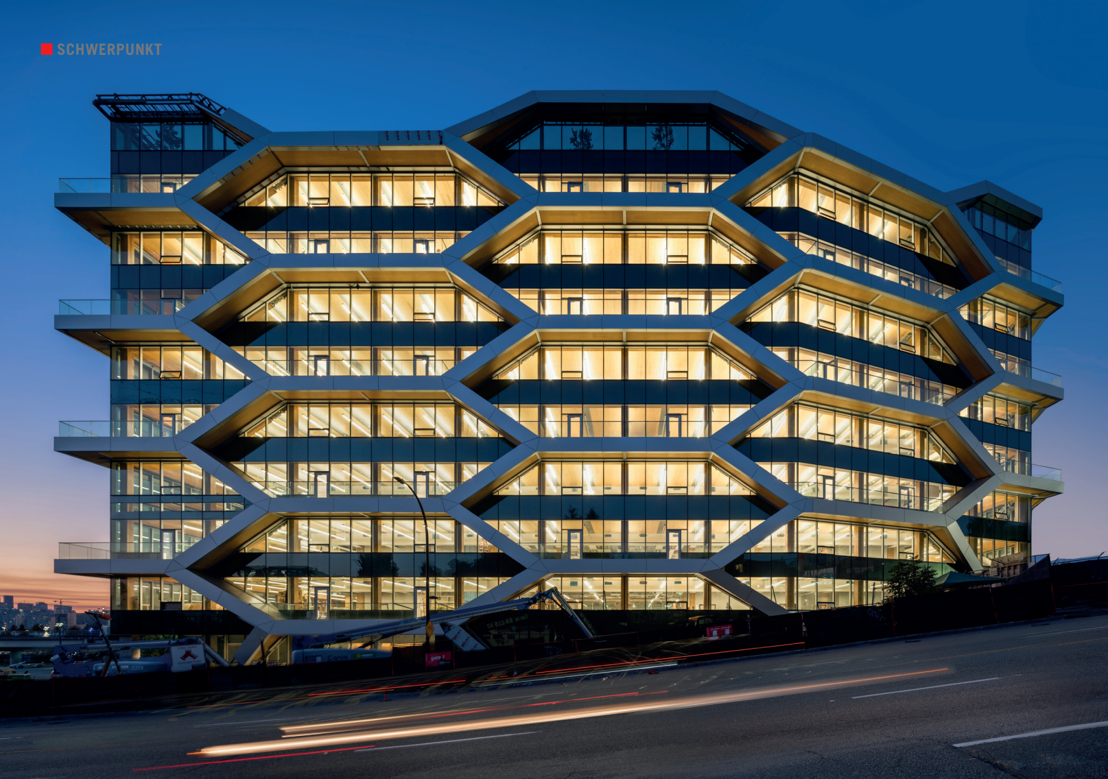
The Hive in Vancouver zählt zu den innovativsten Holzhochhäusern Nordamerikas. Die markante, wabenförmige Fassade ist zugleich Teil des erdbeben-resistenten Tragwerks.
