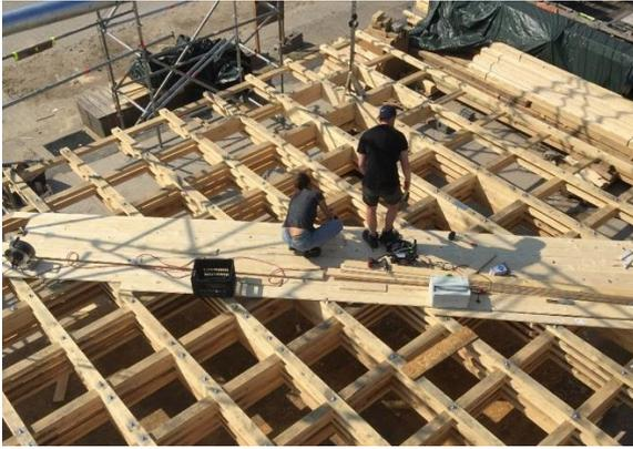
Abbildung 35: Trägerrost aus Altholz
