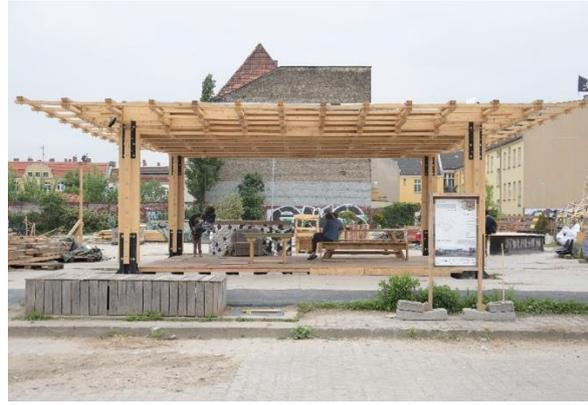
Abbildung 36: Rohbau Holztragwerk aus Altholz
