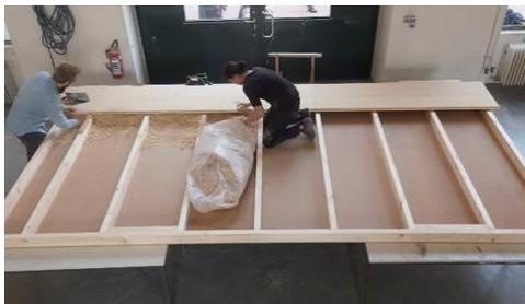
Abbildung 16: Holzrahmen mit Ständern, Einbringen der Einblasdämmung
