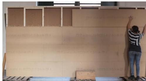
Abbildung 17: Befestigung der Holzweichfaserplatten (außenseitig)
