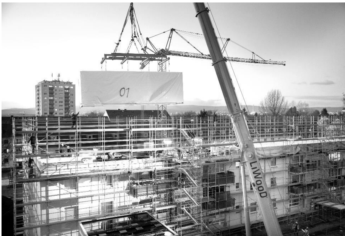
Abbildung 5: Versetzen des ersten Moduls von insgesamt 1.102
