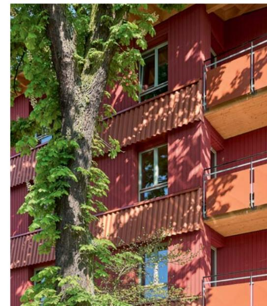
▲ Für den Bereich zwischen Deckenunterkante und Brüstung entwickelten die Architekten Schürzen aus Faserzementplatten und eine Brandsperre aus Stahl
