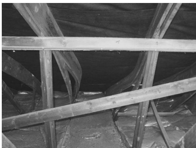
Abbildung 5: Ausknicken von druckbeanspruchten Obergurten an Brettbindern, [5]
