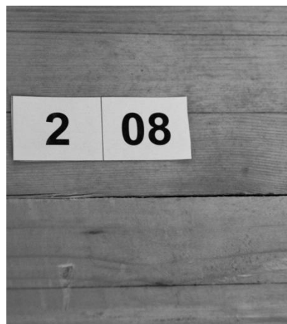
Abbildung 2: Delaminierung in der Klebfuge, [6]
