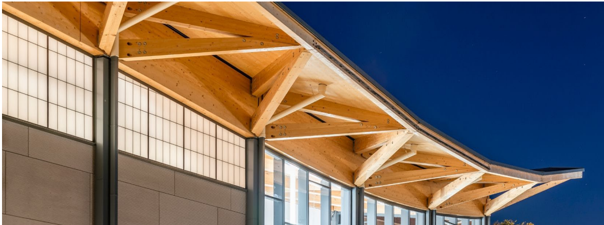
Abbildung 9: Randachse mit 480mm breitem Giebelträger
