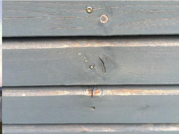
Abbildung 10: Fasadenschalung mit einer Vorvergrauungslasur behandelt, speziell die Kantenbereiche erscheinen relativ ungleichmässig und die Lasur wird flächig abgebaut.
