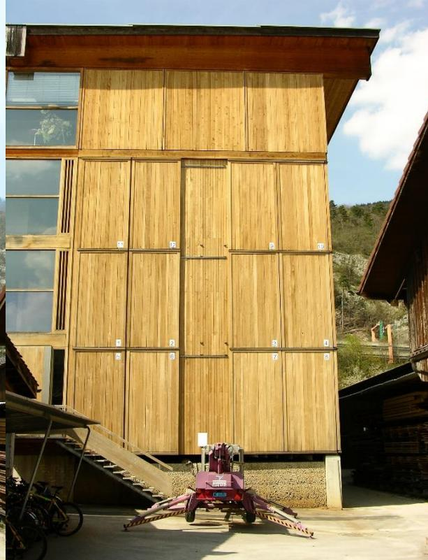
Abbildung 6: Südfassade der Fachhochschule in Biel/Bienne nach 9 Jahren Bewitterung und anschließender Reinigung
