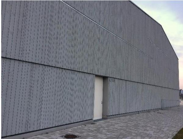
Abbildung 9: Fassade – behandelt mit einer Vorvergrauungslasur, Die Oberfläche wirkt sehr natürlich und ist kaum von einer unbeschichteten, bewitterten Fassade zu unterscheiden.
