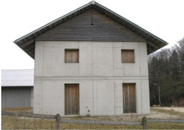
Abbildung 3: Unbehandelte Stülpchalung – Fichte (westexponiert), nach 5 Jahren Bewitterungszeit, die erwartete Vergrauung ist relativ gleichmässig abgesehen vom Einfluss des Vordaches (Volkmer und Höltschi 2008)
