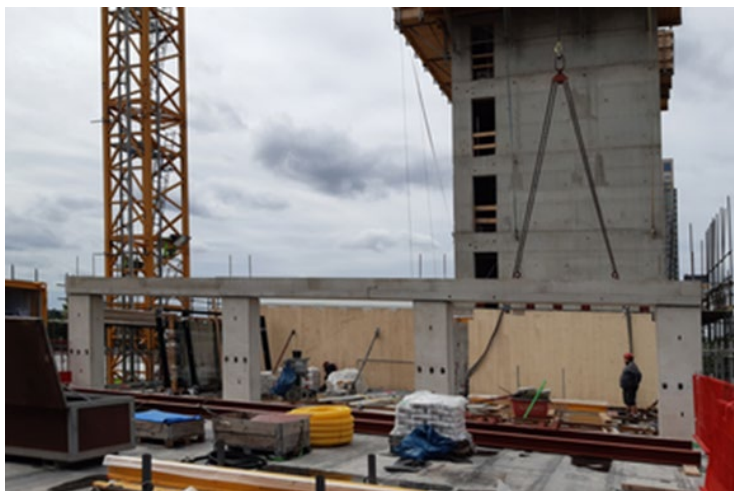
[21-02 Hybrid]; Die hybride Konstruktion des HAUT kombiniert im Wesentlichen einen Treppenhauskern aus Ortbeton mit HBV-Geschossdecken sowie einer Fassade aus nicht tragenden Holzrahmenbauwänden. Foto: Brüninghoff
