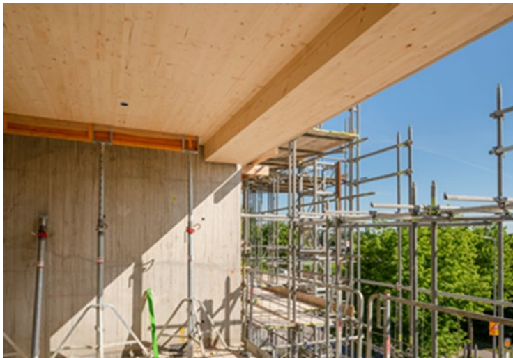
[21-02 Holz_Beton]; Die Geschossdecken bestehen aus Beton in Verbindung mit Brettsperrholz. Foto: Jannes Linders
