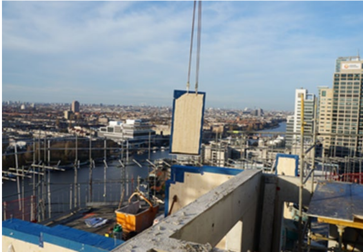
[21-02 Tragwerk]; Für die tragenden Wände und Stützen im Gebäude kommt ebenfalls zu einem großen Teil Holz und Beton zum Einsatz. Foto: Brüninghoff
