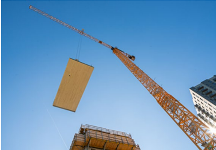
[21-02 Kran]; Dank des hohen Vorfertigungsgrads ließ sich ein schneller Baufortschritt erzielen Foto: Jannes Linders
