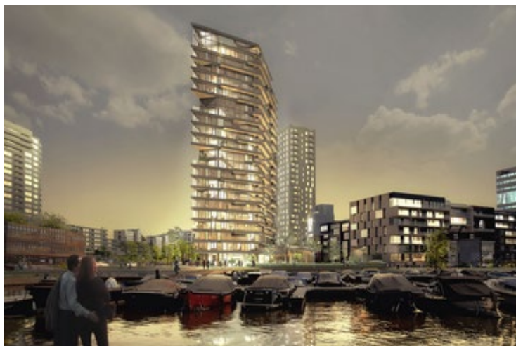
[21-02 HAUT]; In Amsterdam – in unmittelbarer Nähe zur Amstel – ist der Wohnturm HAUT entstanden. Foto: © Zwartlicht / Team V Architecture
