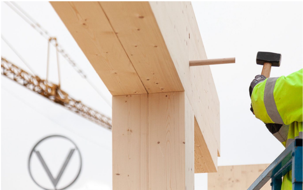
Abbildung 20: Montage Buchendübel – Foto: Moritz Groba
