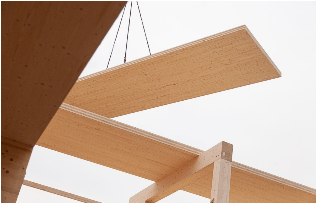
Abbildung 8: 15 x 3m große Brettsperrholzelemente – Foto: Moritz Groba
