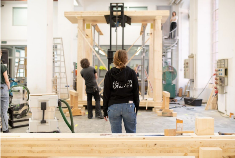
Bau des 1:1-Modells im Natural Building Lab Bild: Jan Rottler / Partner und Partner Architekten
