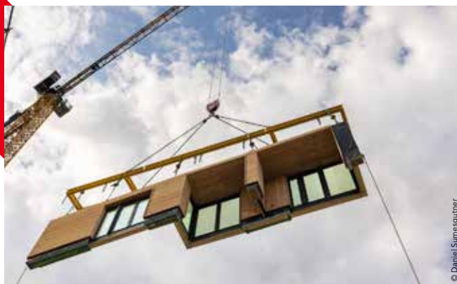
2.770 vorgefertigte Holzbauelemente ließen das Projekt emporwachsen.
