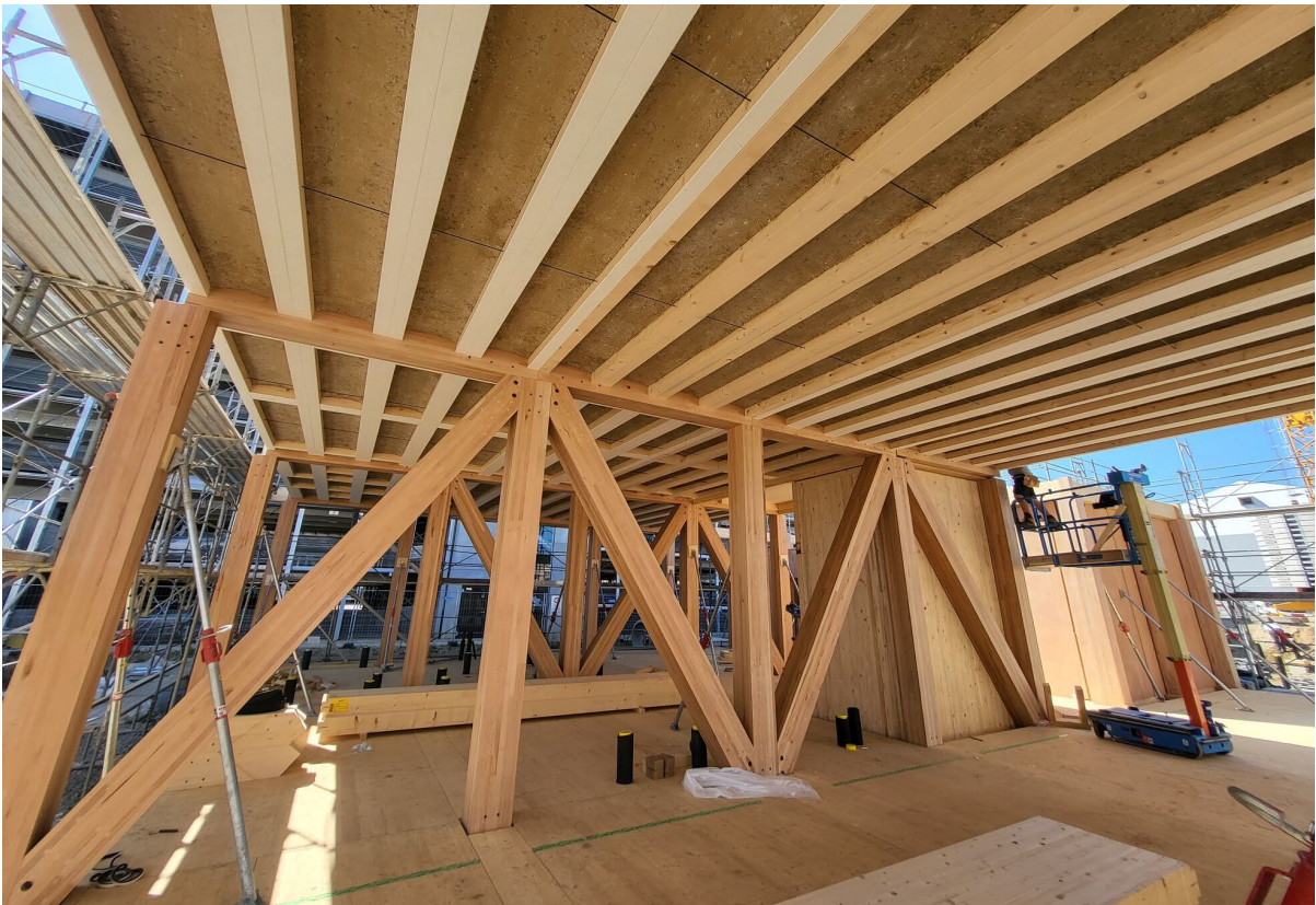
Abbildungen 13: Montage des ersten, der fünf Geschosse und der Bodenelemente des HORTUS-Baus. Montagestart: Oktober 2023
