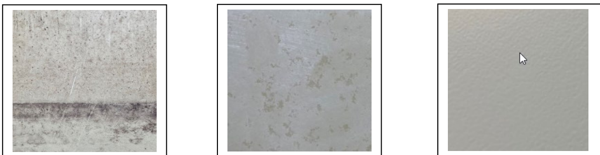
Abbildung 4: Zustände HPL-Platten – links nach rechts – Rückbauzustand, geschliffen und neu beschichtet
