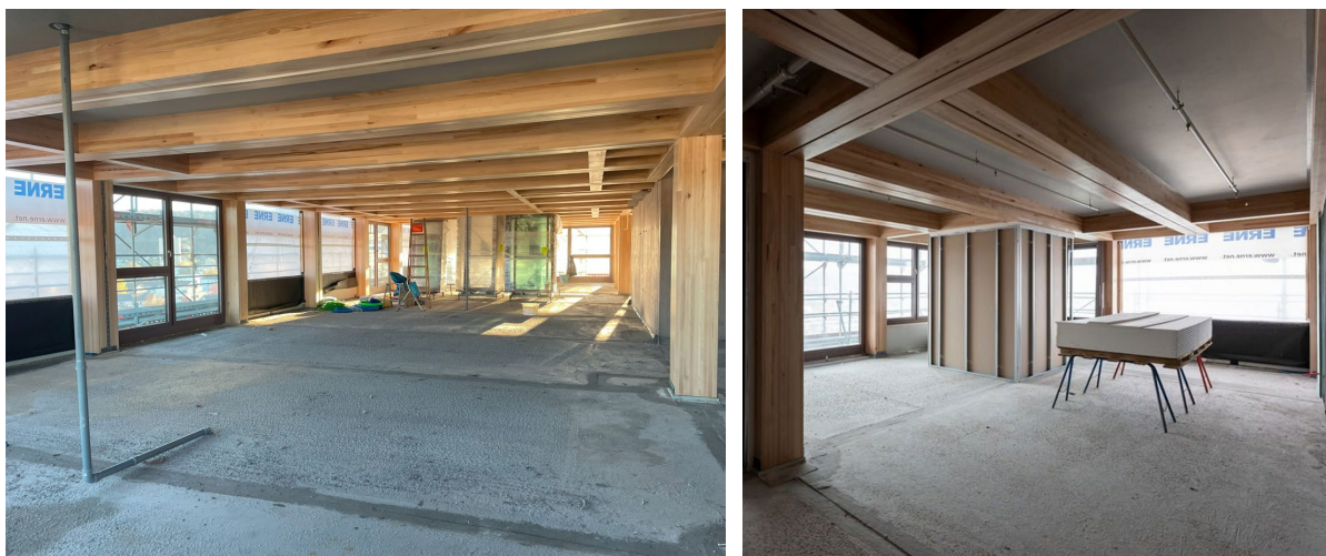
Abbildung 14: Innenansichten nach abgeschlossener Rohbaumontage
