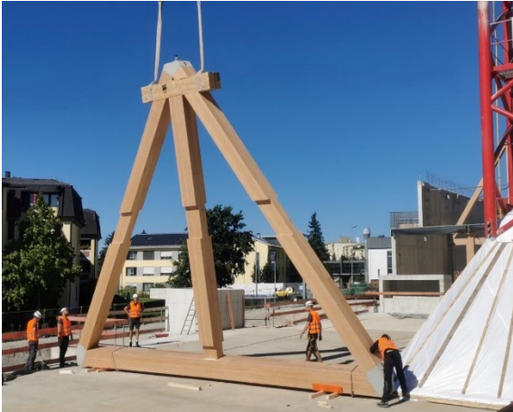
Abbildung 9: Das Sprengwerk bereit zur Montage
