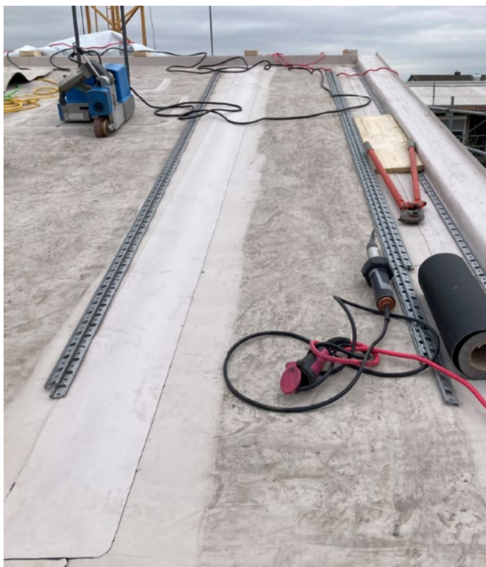
Abbildung 7: Dachbahn kombiniert alt / neu
