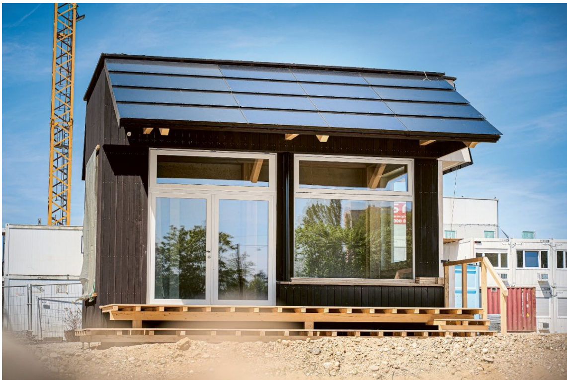
Abbildung 2: Mock-up des Hortus Baus auf der Baustelle in Allschwil, BL
