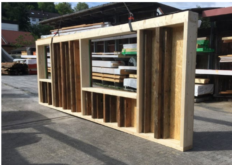
Abbildung 6: Außenwand mit neuem und recyceltem Holz
