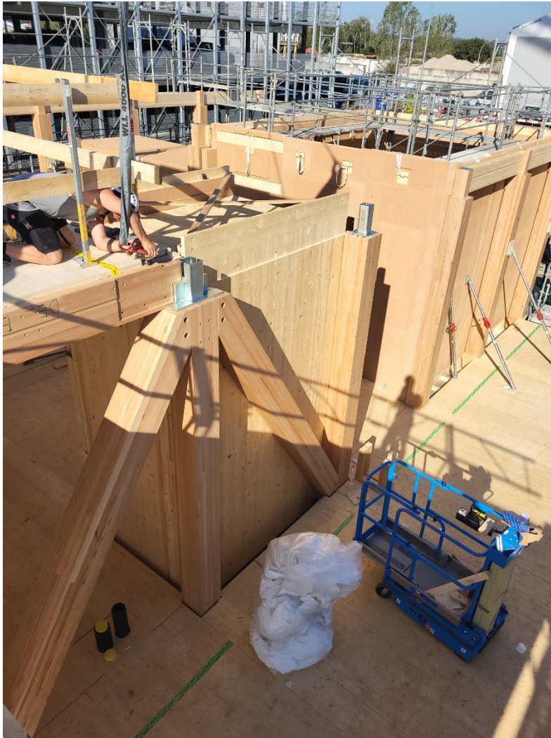
Abbildung 10: Treppenhaus mit Brettstapel-Elementen.
