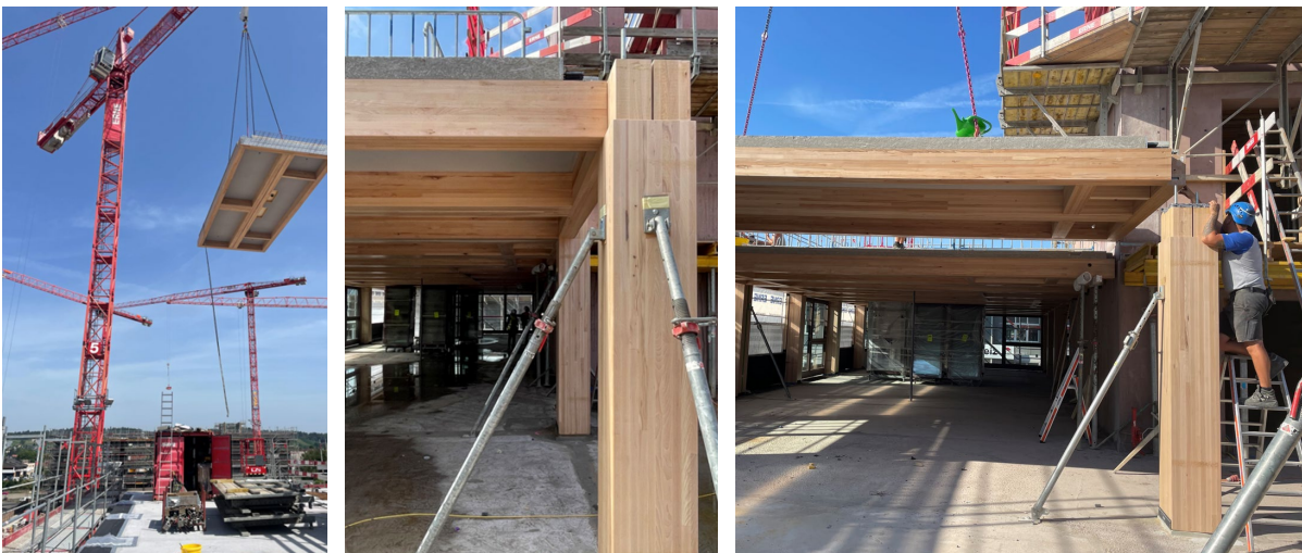
Abbildung 13: Montage Deckenelemente
