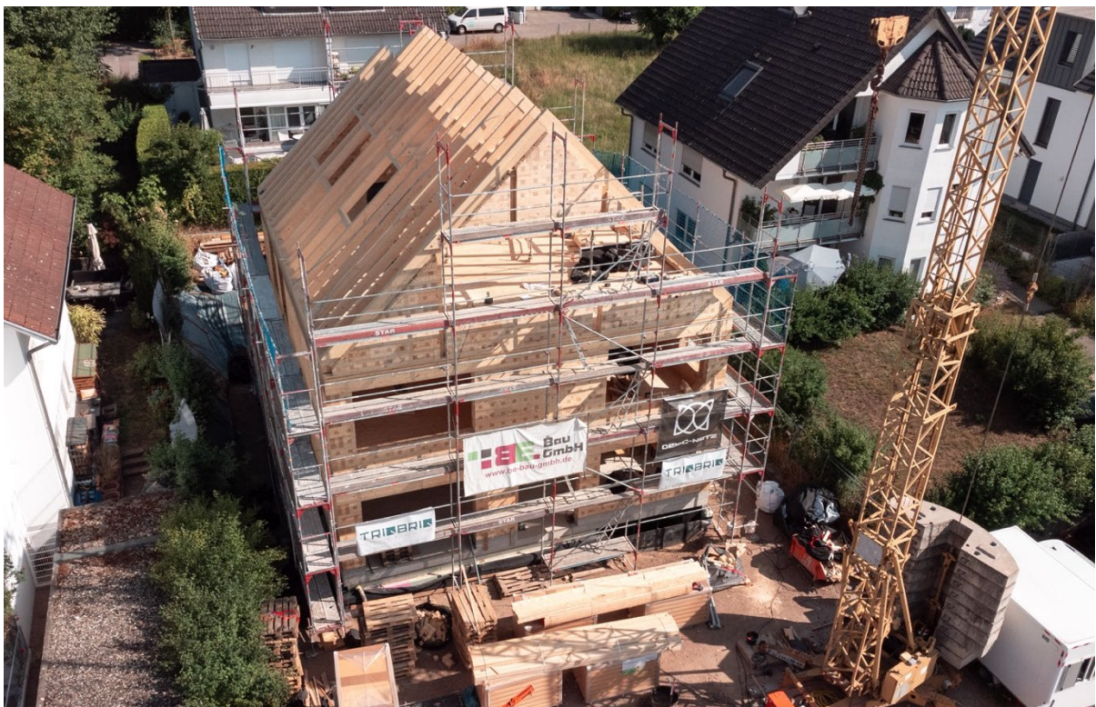
Abbildung 2: TRIQBRIQ Rohbau in Frankfurt
