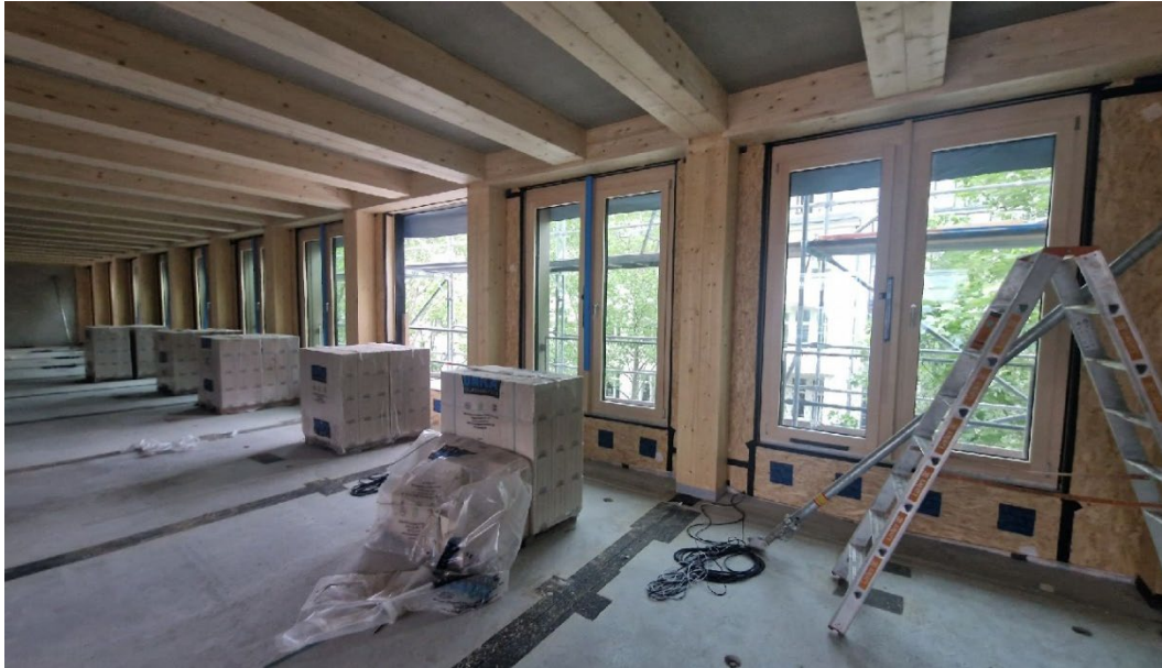
Abbildung 9: Blick in das Hinterhaus nach Montage der Außenwandelemente (Sieveke)
