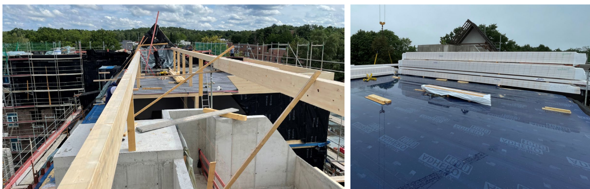
Abbildung 7: Bild links; Montagezustand Aufstockung (© Holzbau Gehrmann)
