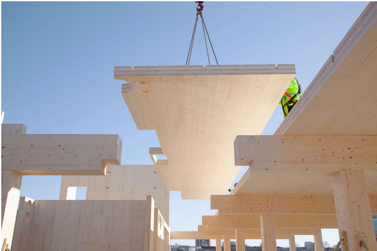
Abbildung 4: Millimetergenaue Vorfertigung und Montage – Foto: Moritz Groba
