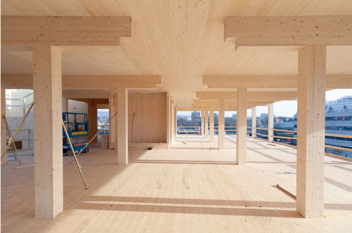
Abbildung 31: Freier Installationskorridor, Rohbauphase – Foto: Moritz Groba
