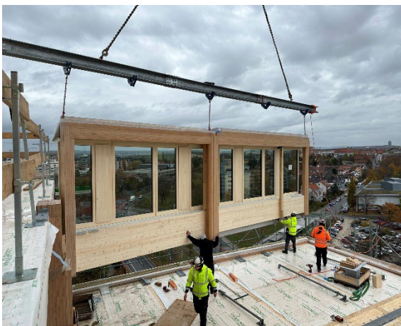
Abbildung 11: Tragkonstruktion und Teile der Gebäudehülle wurden gemeinsam montiert
