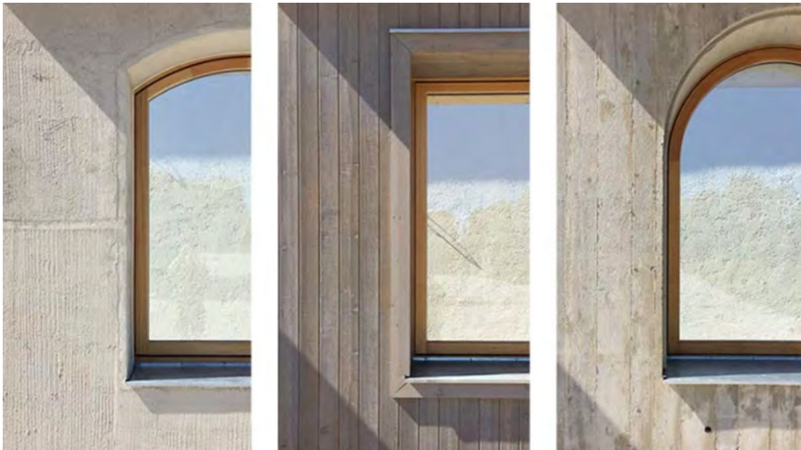
Abbildung 4: Unterschiedliche Ausbildung der Fensteröffnung in der Wand aus Mauerwerk, Holz und Beton.
