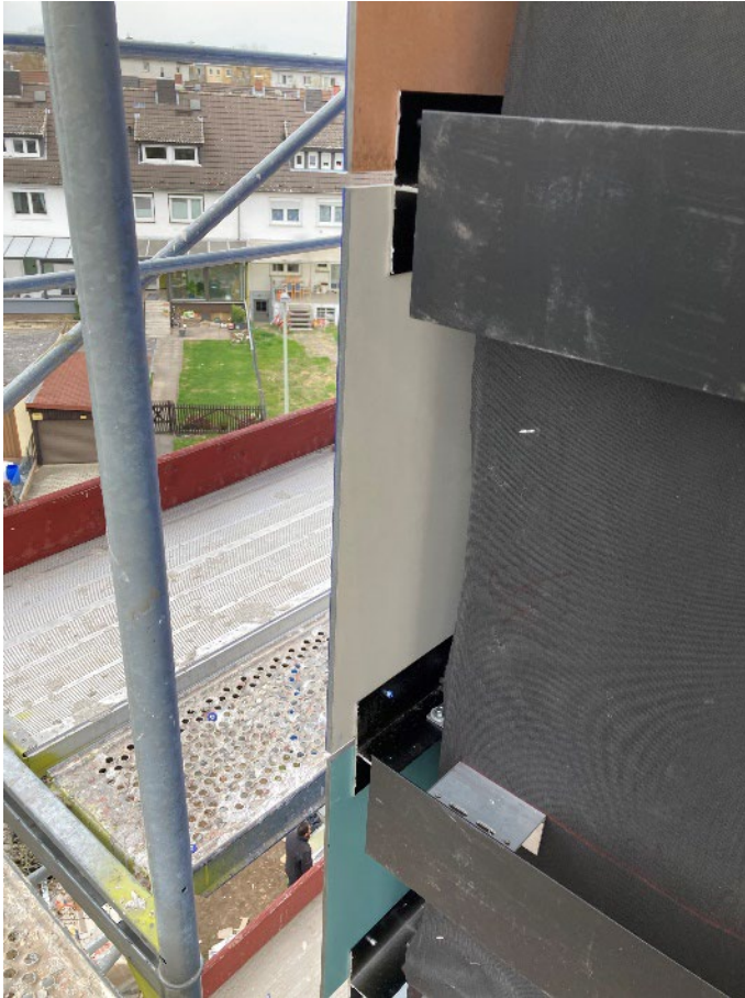
Abbildung 9: Fassadenplatten Eckausbildung (Rückseite) mit UK aus Aluminium
