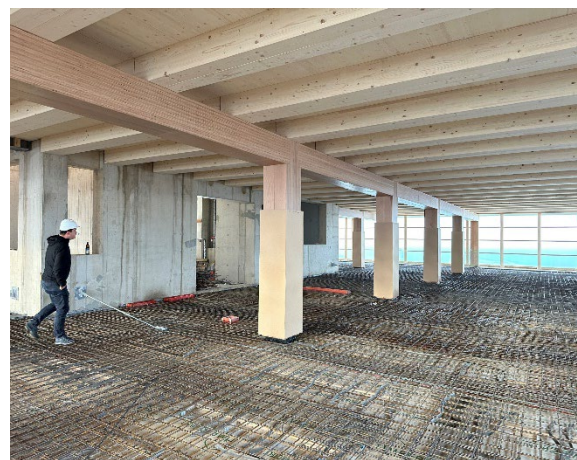
Abbildung 12: HBV-Decke bereit zum Betonieren
