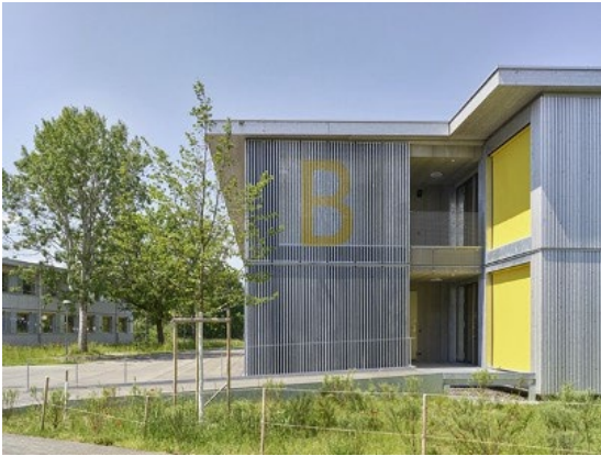
Abbildung 4: Schulanlage Brünnen Bern
