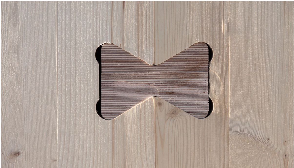
Abbildung 9: X-Fix Verbinder in einer der Wände – Foto: Moritz Groba
