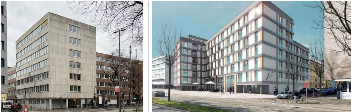
Umnutzung eines Bürogebäudes zum Studentenwohnheim in Köln Leistung: Planung und thermische Hülle + Fassade
