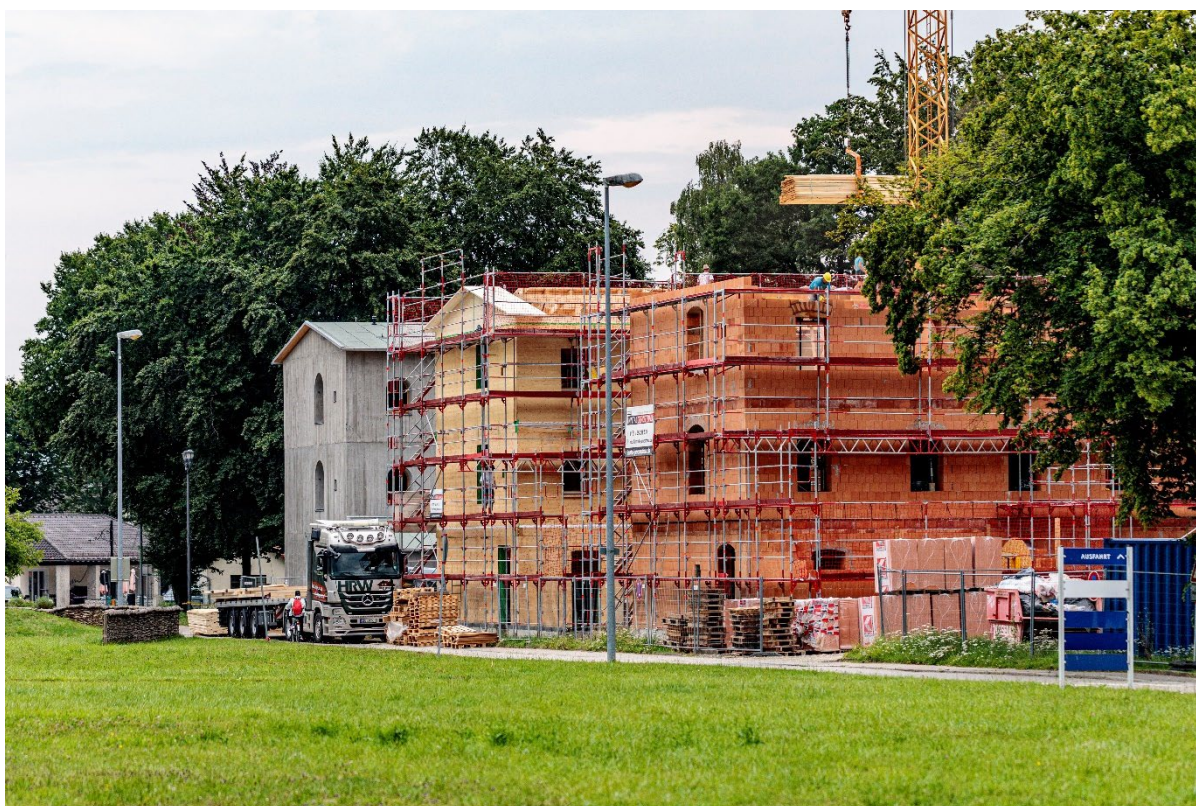
Abbildung 2: Die drei Forschungshäuser im Bau.
