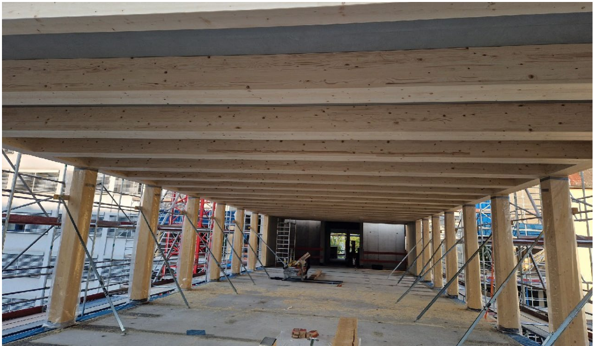
Abbildung 8: Blick in das Hinterhaus mit Tragkonstruktion und Decken (Sieveke)
