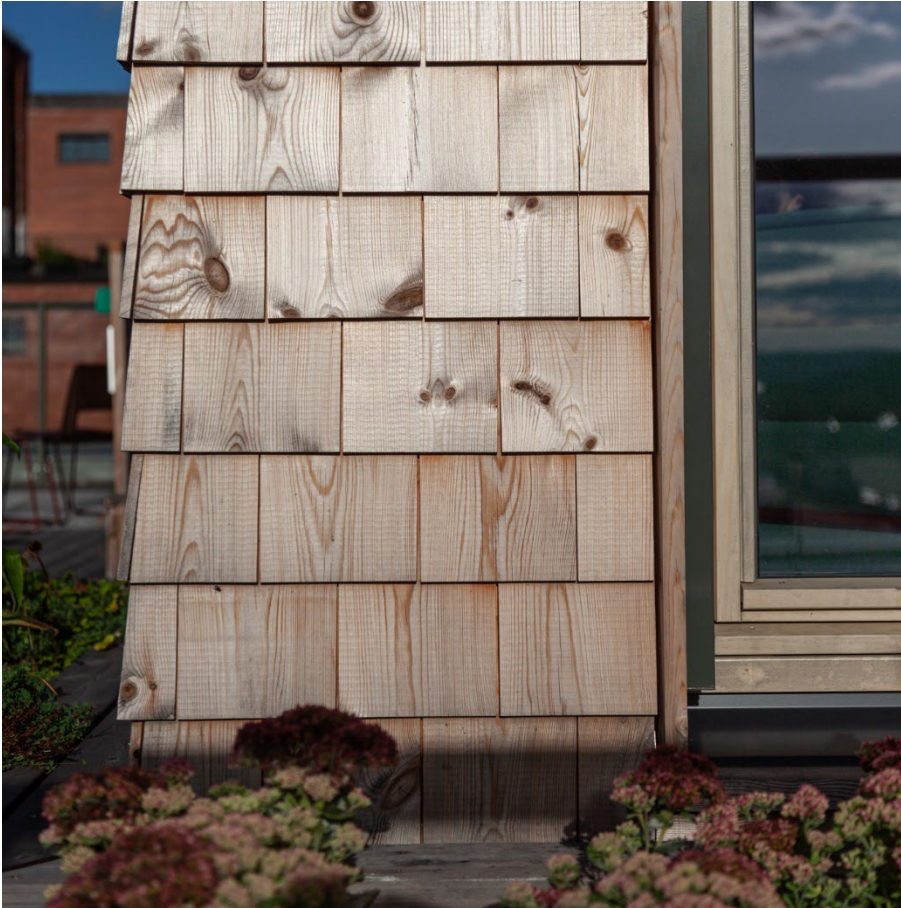
Abbildung 54: Fassade an der Dachterrasse – Foto: Moritz Groba
