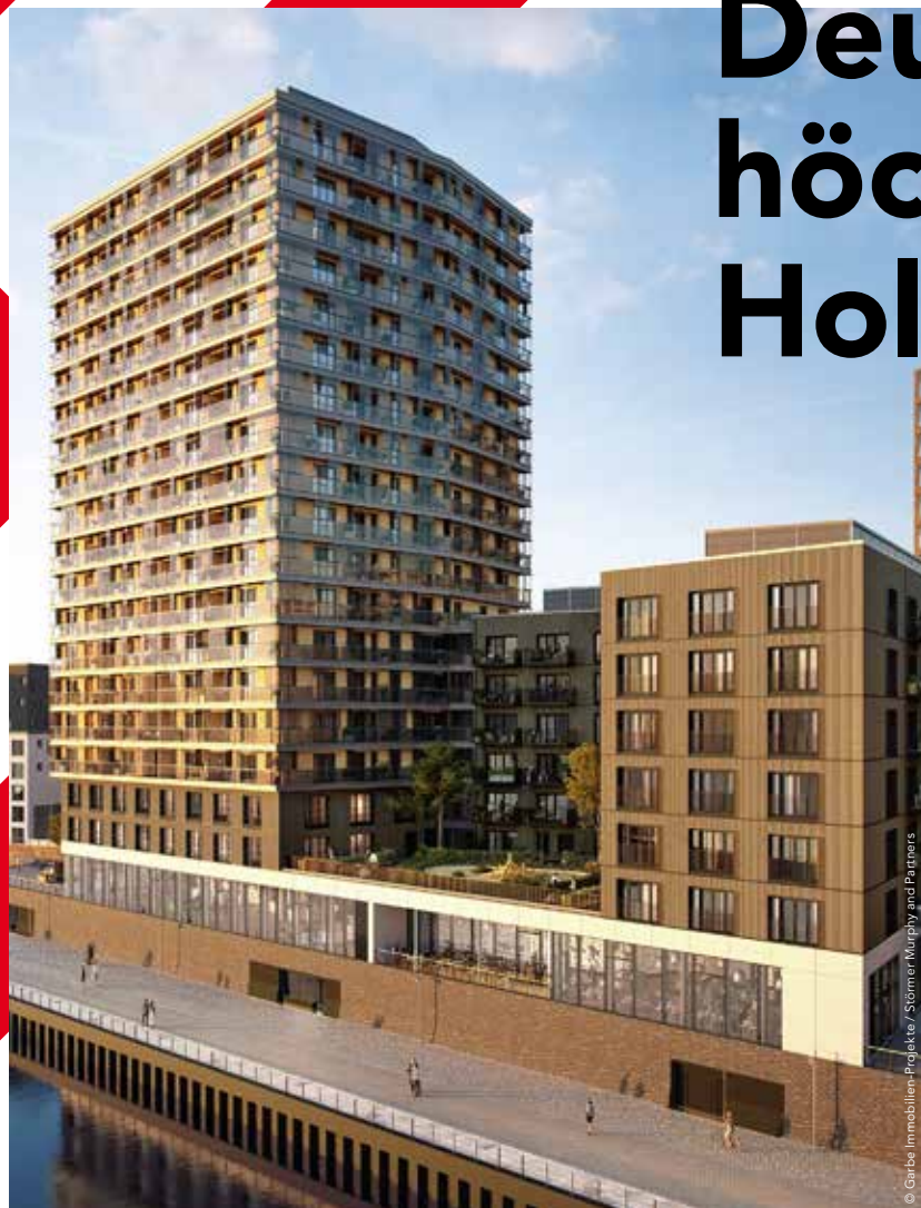
„Roots“ in der Hamburger HafenCity – Deutschlands höchstes Holzhochhaus. 72 m Gesamthöhe, 20 Nutzgeschosse, davon 16 in Holzbauweise.
