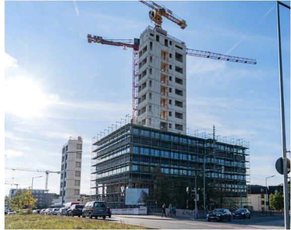
Abbildung 10: Die Montage des Holzbaus erfolgte nach Abschluss der Stahlbetonarbeiten
