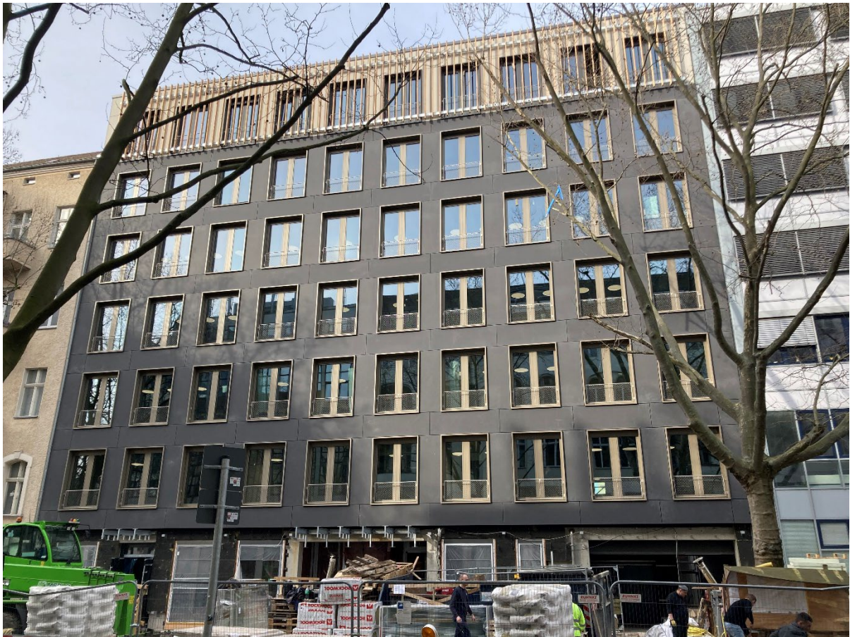
Abbildung 11: Ansicht von der Keithstraße April 2024 (HPP Bauleitung)
