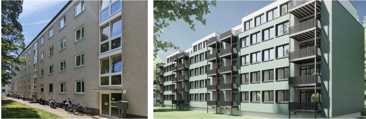
Sanierung von zwei Wohnquartieren in Erlangen Leistung: Planung und thermische Hülle + Fassade
