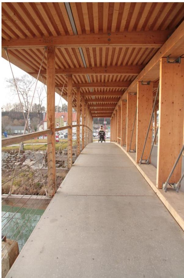
Photo 6 : Vue intérieur avec la poutre centrale
