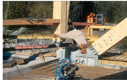
Une articulation parfaite peut aussi servir comme un axe de rotation pour pivoter des éléments préfabriqués, comme des portiques transversaux, afin de simplifier le montage du pont des Fayette, F. (voir ci-contre).
