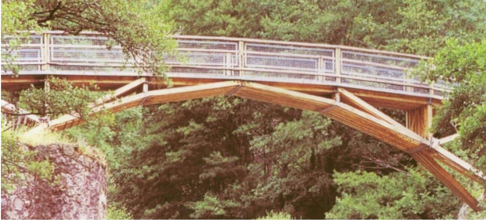
Soutien de la poutre supérieure par un arc polygonal et des poteaux, ingénieur J. Anglades
