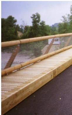
Consoles démontables pour les superstructures telles que garde-corps protégés par couvertines métalliques.
