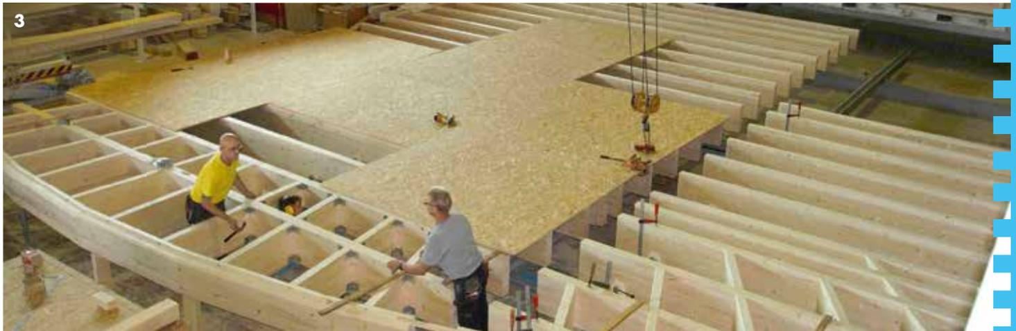
3 / Restaurant : Plancher d'étage de 40 cm de hauteur avec poutres de rive courbes et poutrelles ajourées sur tectofix 3000
