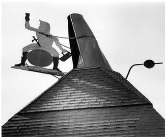
Adoptant les mêmes principes que les ingénieuses girouettes d'extraction statique des séchoirs à houblons des brasseries des Hauts de France, l'ensemble des locaux du groupe scolaire est mis en faible dépression de l'ordre de 2Pa.
