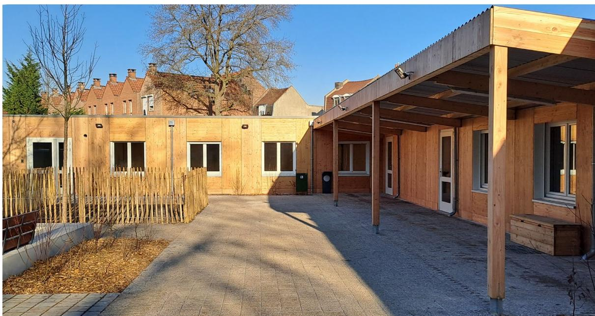
Le bâtiment est préfabriqué de conception et très bien isolé (matériaux biosourcés) pour répondre aux critères de sobriété énergétique. Les modules 3D sont composées de bois massifs type CLT sur l'ensemble des parois et assurant la solidité mais également la durabilité et le déphasage thermique. D'un point de vue carbone, le bâtiment assure un stockage de Co<sub>2</sub> supérieur au béton du fait de sa conception tout bois.
