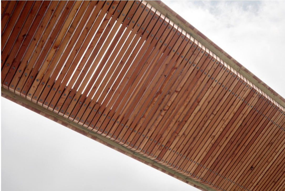
Abbildung 6: Brückenuntersicht, luftumspülte Lärchenrippen Foto: Ralph Feiner
