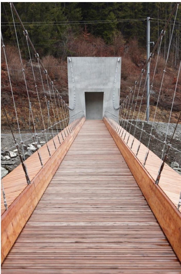
Abbildung 5: Auf der Brücke entsteht ein trapezförmiger Raum Foto: Ralph Feiner
