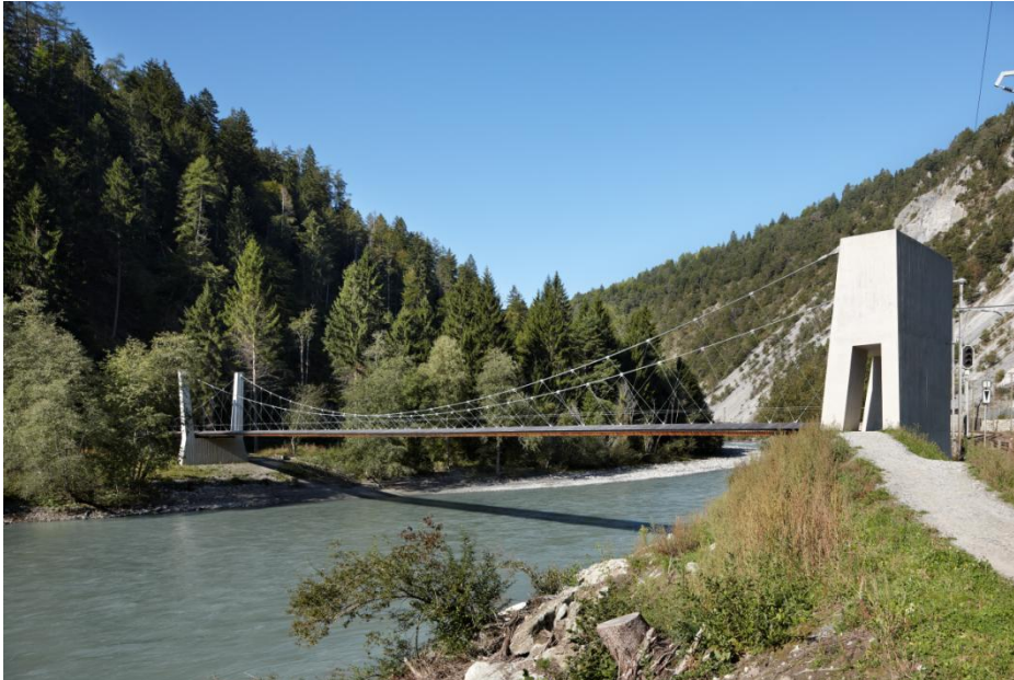
Abbildung 4: Zugang zur Brücke von der Bahnstation Trin Foto: Ralph Feiner
