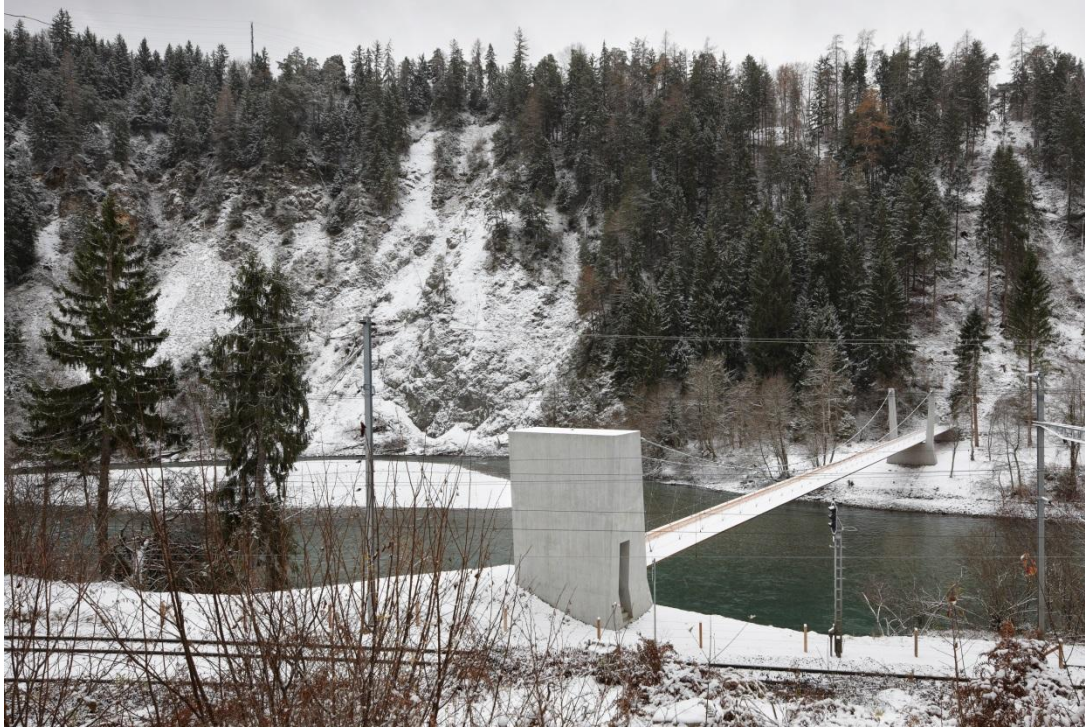
Abbildung 3: Linkes Brückenwiderlager mit Hinterausgang Foto: Ralph Feiner
