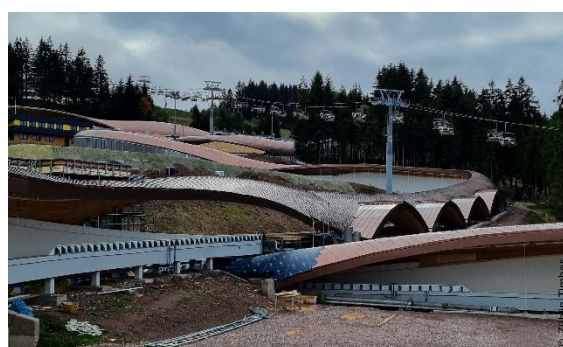
Abbildung 9: Fertiges Bahndach
