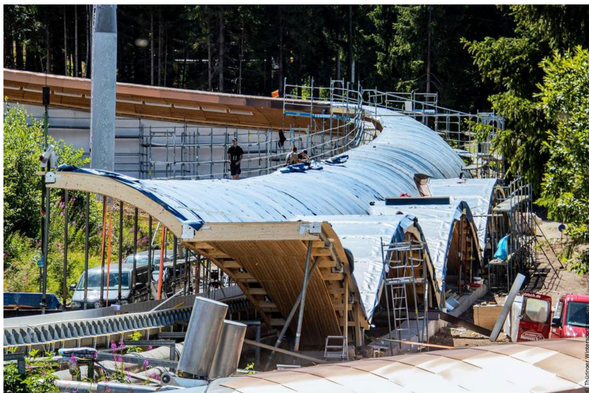
Abbildung 5: Gerade zwischen K13 und K14 im Bauzustand
