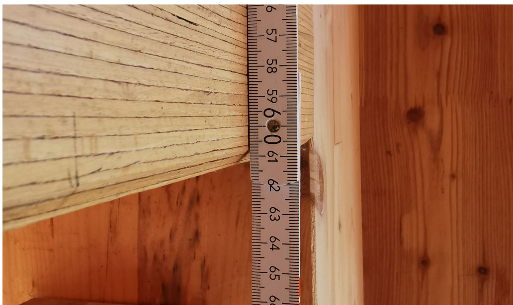
Abbildung 6: Messung der Trägerhöhe (ca. 615 mm)
