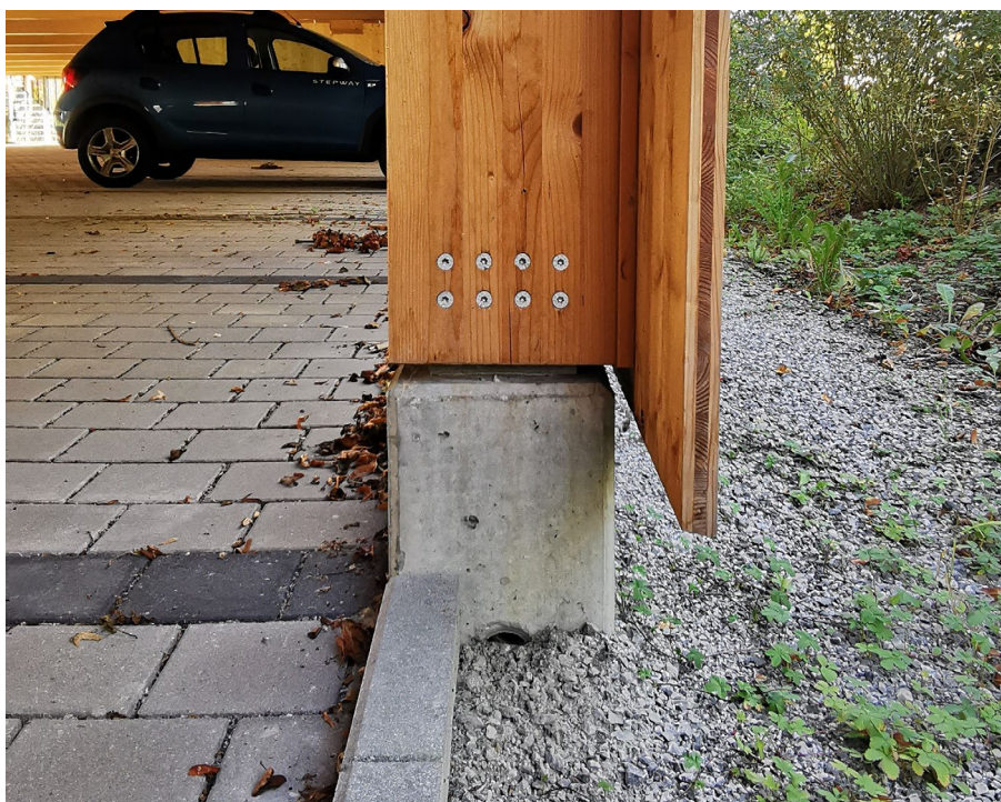
Abbildung 9: Betonsockel EG und Opferbrett mit Überstand zum Schutz der Stütze
