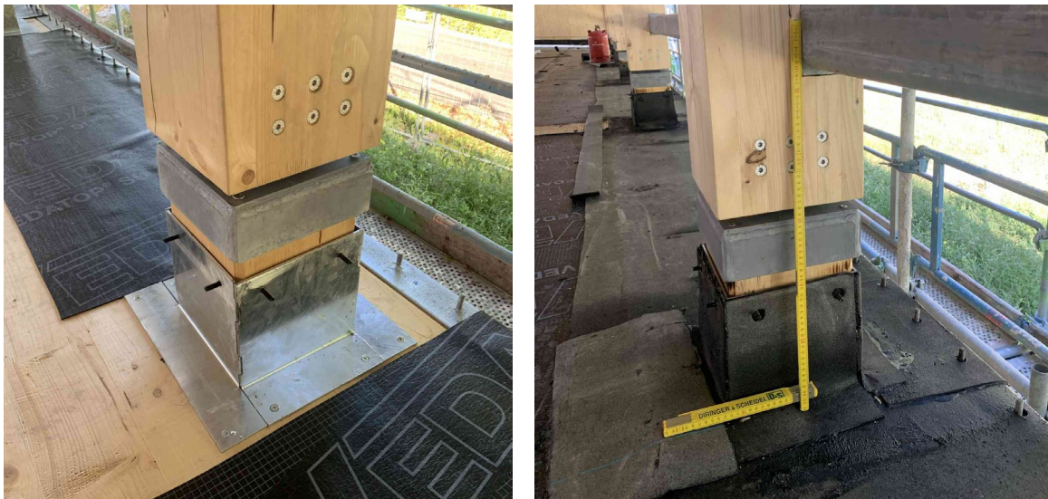
Abbildung 8: Abdichtung Stütze an Zwischendecke im Bauzustand
