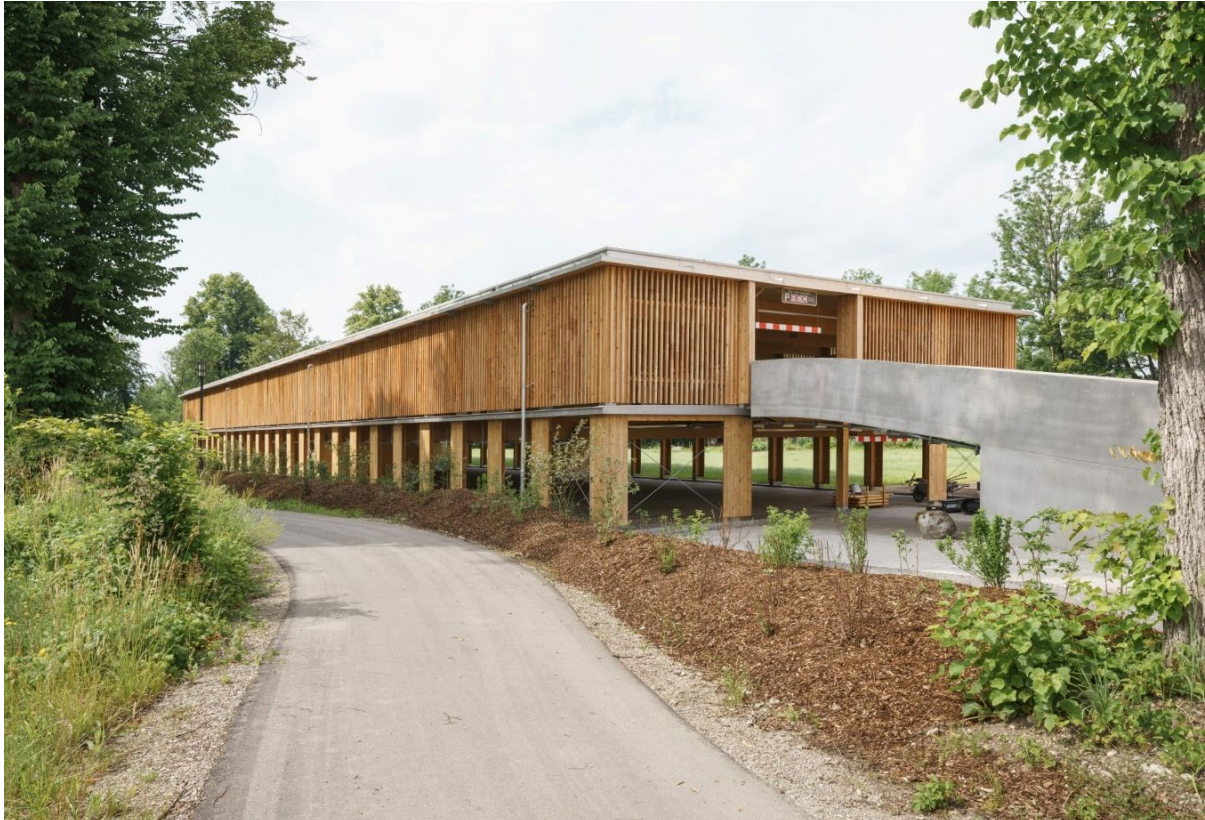
Abbildung 2: Einfahrtsrampe aus Stahlbeton
