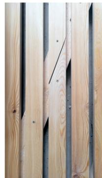
Zu guter Letzt verrät Etzelstorfer noch ein Detail, inspiriert von Juri Troys "Strohfluh": eine diagonalverlaufende Unterkonstruktion hinter der vertikalen Lamellenfassade, beispielsweise im Zen-Garten. Das sorgt nicht nur für eine bessere Hinterlüftung bzw. Entfeuchtung, sondern auch für eine spannende Optik. ■
