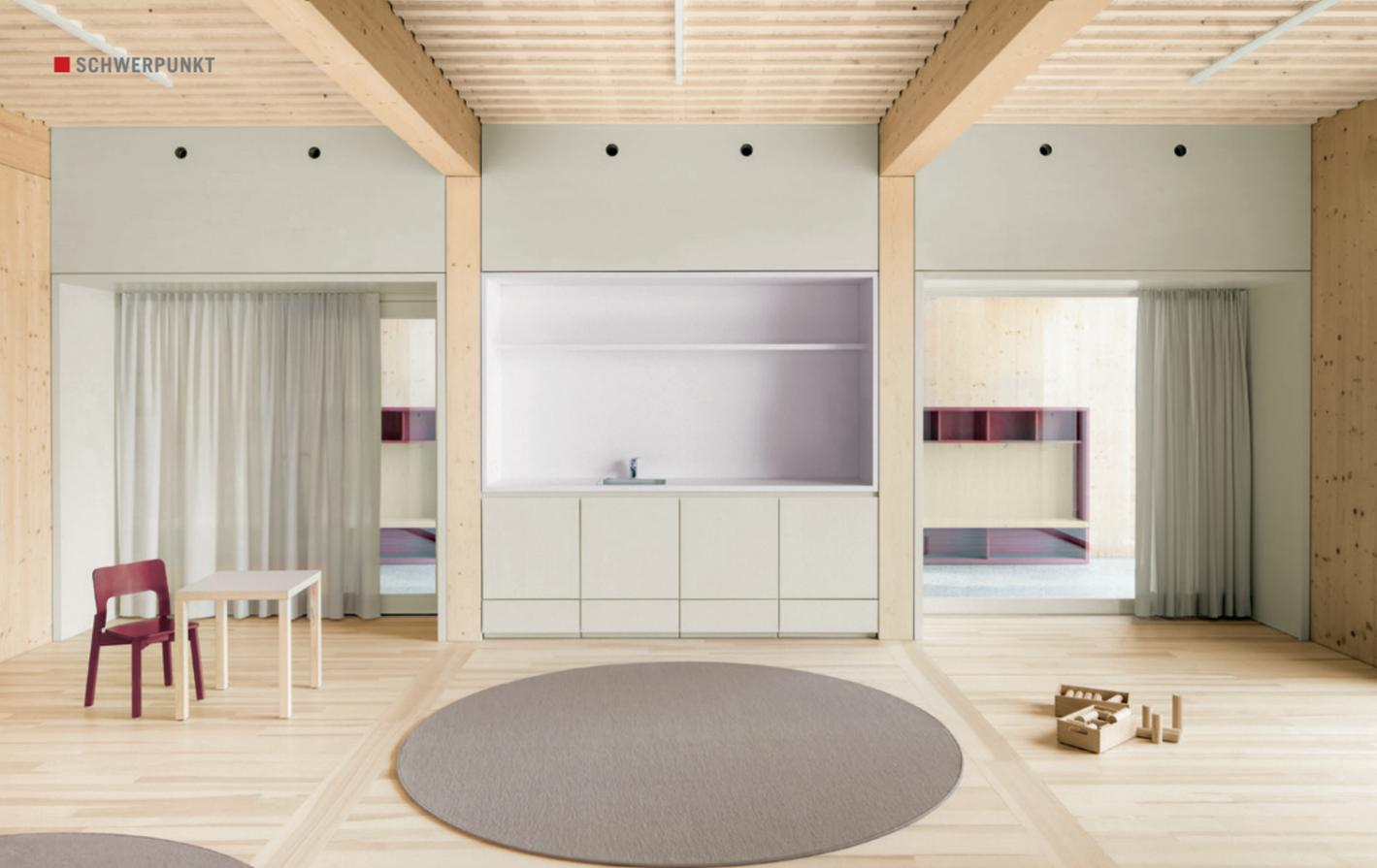
Bewusst ist die Primärtragstruktur der BSH-Stützen und -Träger im Innenraum ablesbar. Dies prägt die Raumstruktur.
