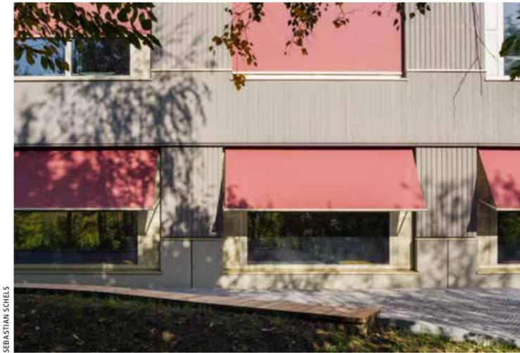
◀ Fassadenspiel: Die Schalung wurde einmal mit Fuge verbaut, einmal ohne. Zuvor wurde sie mit einer Applikation vorvergraut
