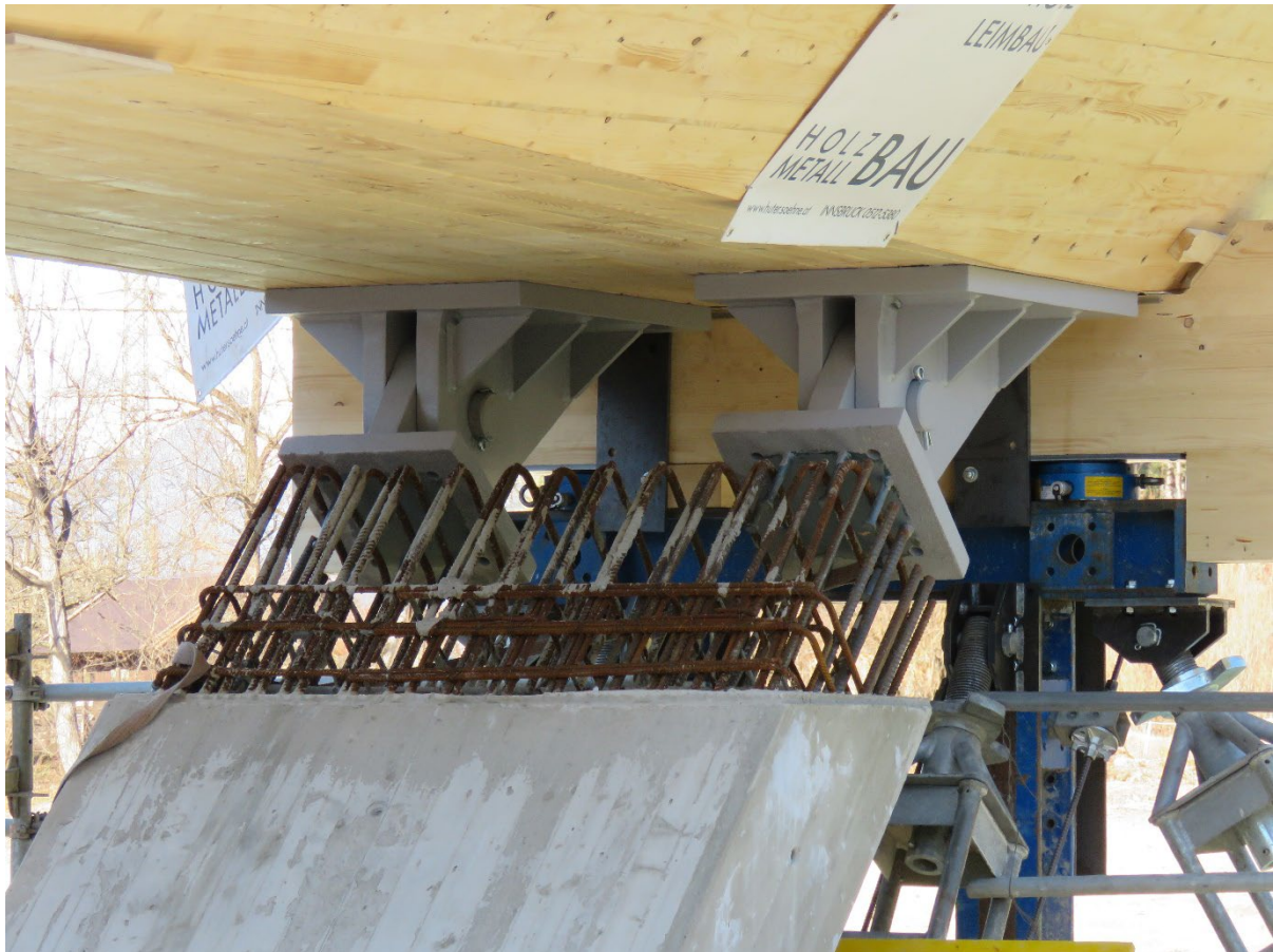
Abbildung 5: Randfeld auf Hilfsunterstellung, Stützenkopf nach Tragwerksvershub
