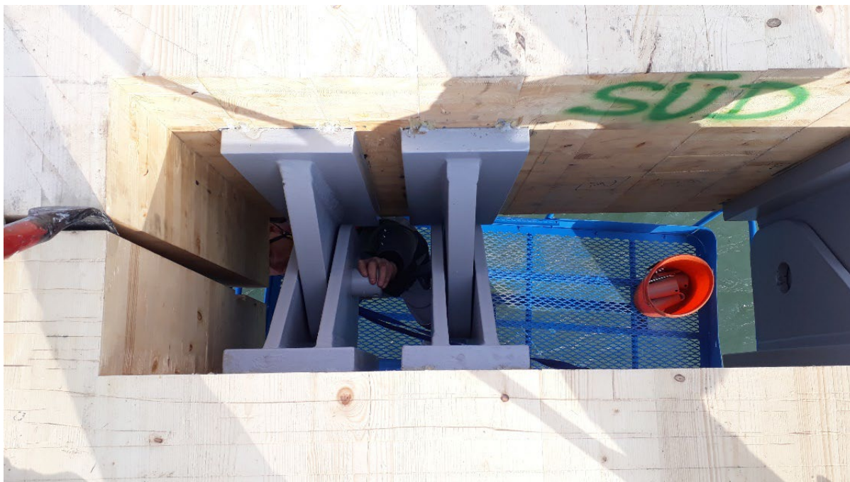
Abbildung 3: Abbildung des Gerbergelenks – Draufsicht
