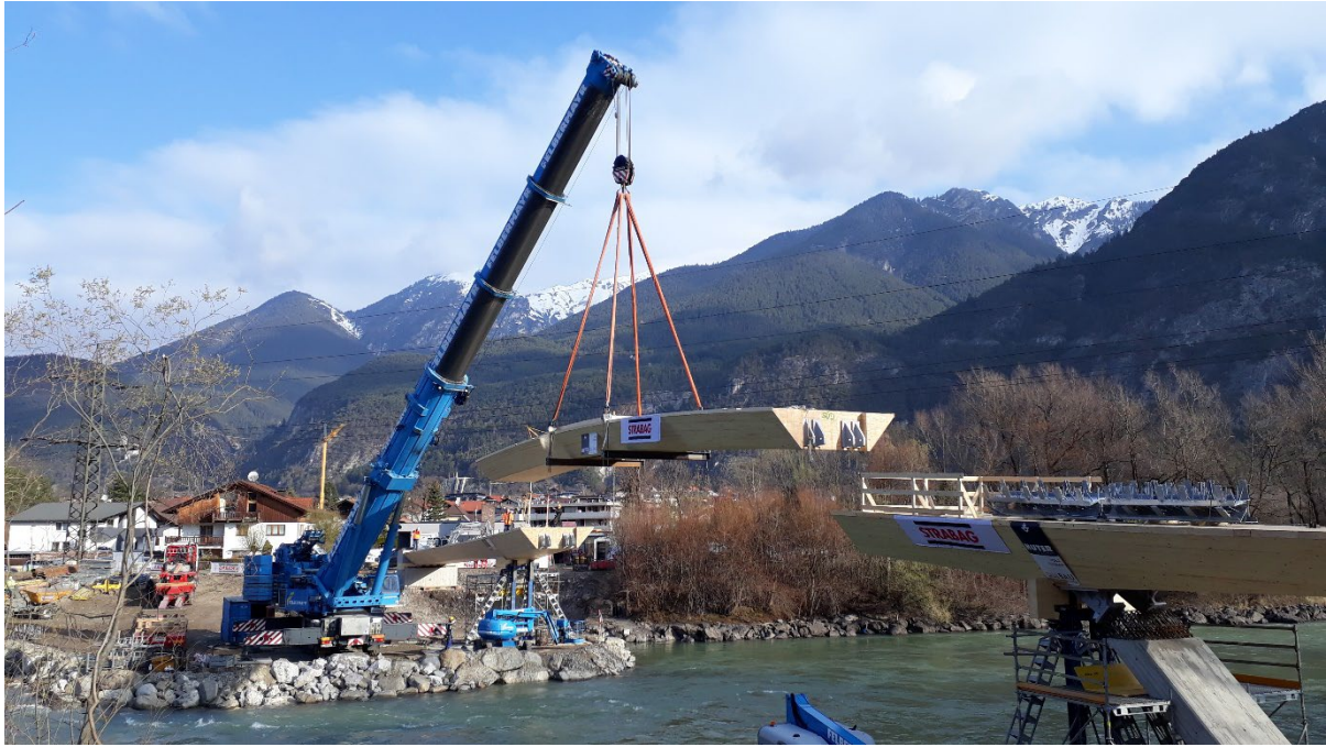
Abbildung 6: Einheben des Mittelfeldes
