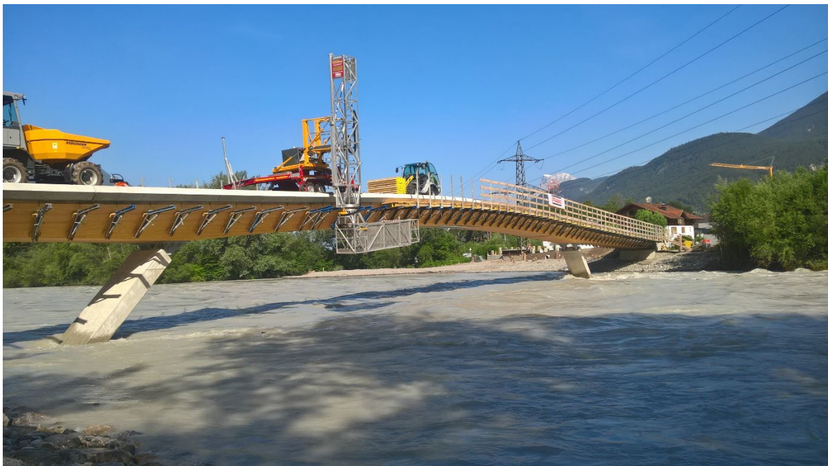
Abbildung 7: Betonarbeiten abgeschlossen – Abbau des Hilfsgerüsts
